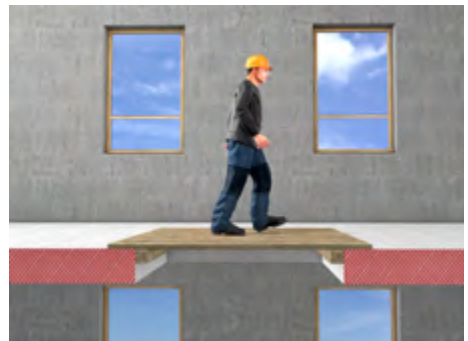
Abb.4: Öffnungen oder Vertiefungen müssen umwehrt oder begehbar und unverschieblich abgedeckt oder mit tragfähigem Material verfüllt sein.
