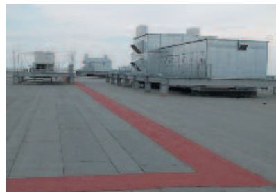
Bild 3-26: Laufmatten auf einem Flachdach
