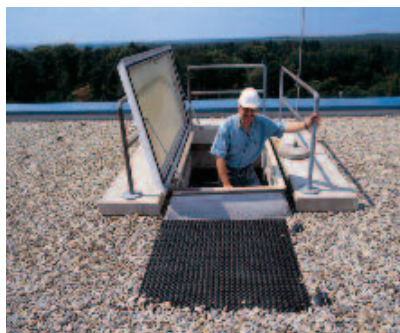
Bild 3-11: Zugangsöffnung mit Geländern an drei Seiten gesichert
