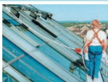
Bild 3-21: Anseilschutz mit beweglicher Anschlageinrichtung
