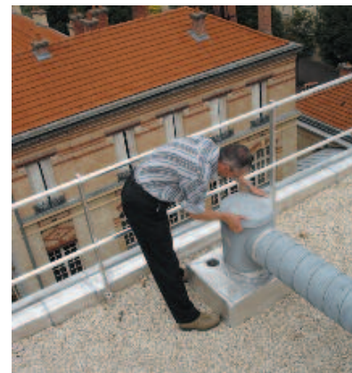
Bild 3-27: Fest montiertes Geländer
