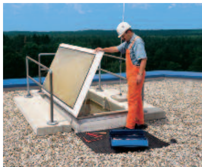
Bild 3-11: Zugangsöffnung mit Geländern an drei Seiten gesichert
