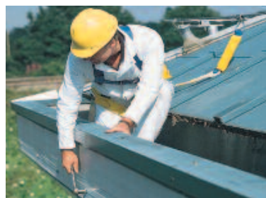
Bild 3-20: Unterspannung einer Lichtkuppel
