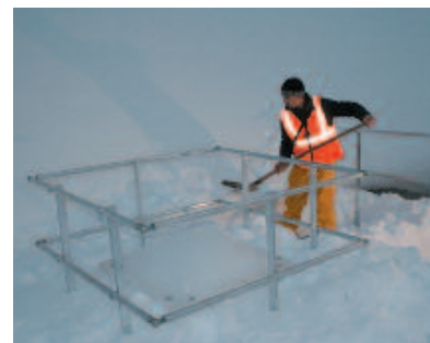
Bild 6: Umwahrung einer Lichtkuppel und Geländer an der Dachaußenkante
