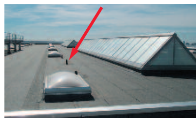
Bild 3-41: Einzelanschlagpunkte
