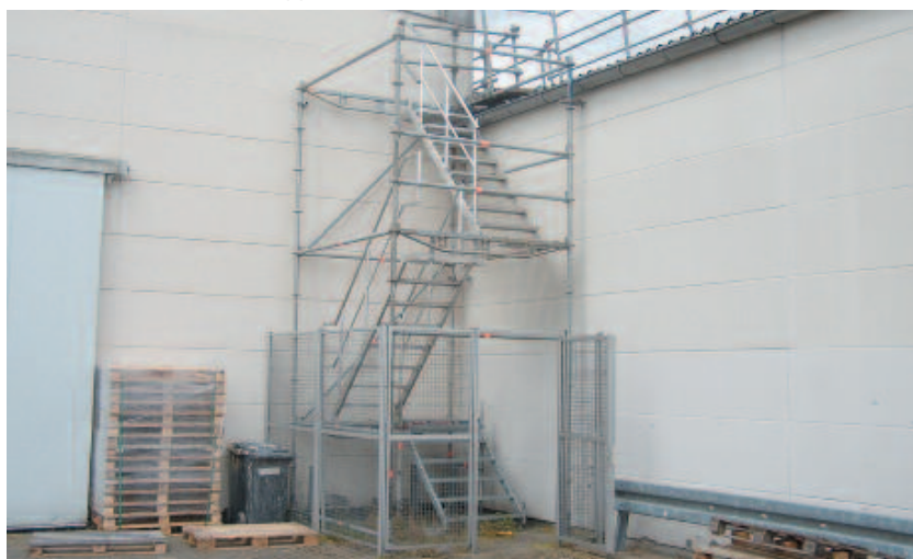
Bild 3-4: Verschießbarer Treppenturm
