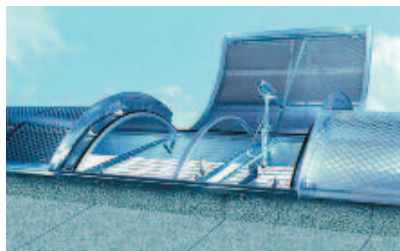
Bild 3-32: Überdeckung an einem Rauch-Wärme-Abzug
