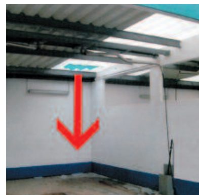
Bild 1: Absturz durch Lichtplatte
