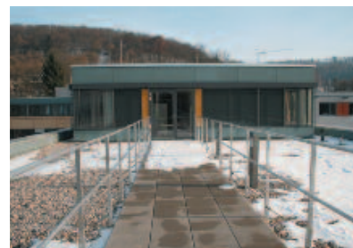
Bild 3-15: Geländer verhindert das Verlassen des Verkehrsweges, Beispiel 2
