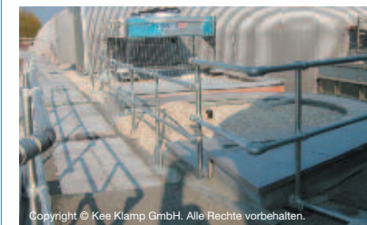
Bild 3-30: Temporäre Geländer, Beispiel 2
