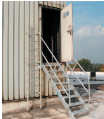
Bild 3-5: Treppe als Zugang
