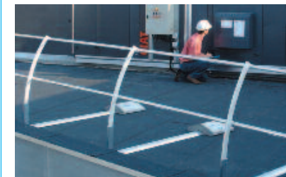
Bild 3-30: Temporäre Geländer, Beispiel 2
