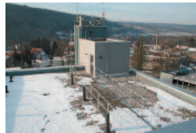
Bild 3-15: Geländer verhindert das Verlassen des Verkehrsweges, Beispiel 2
