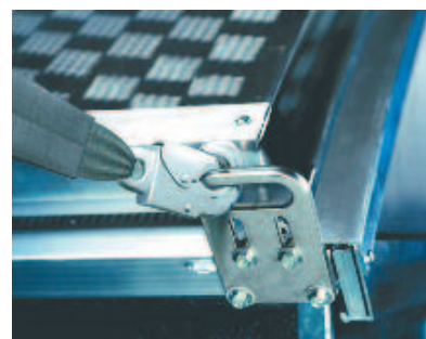
Bild 3-36: Aufsatzkranz mit Anschlag-einrichtung an einer Lichtkuppel
