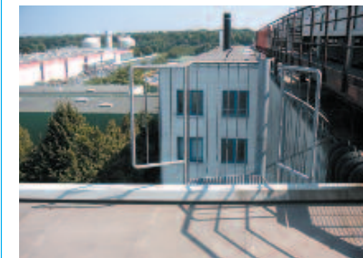
Bild 3-9: Steigleiter mit verlängerten Holmen zur Vorgabe der Gehrichtung
