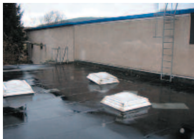
Bild 2-2: Nicht durchsturz sichere Lichtkuppeln im Bereich wartungsbedürftiger Anlagen
