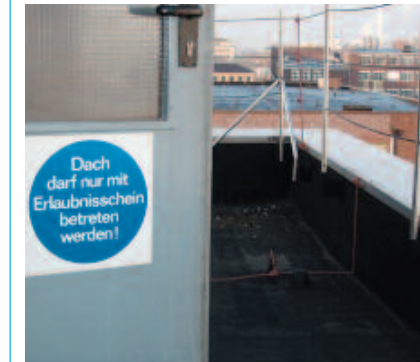
Bild 3-3: Verschiebbare Zugangstür mit Hinweisschildern
