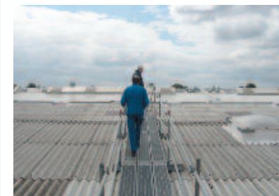
Bild 3-17: Laufsteg über Faserzement-Wellplatten
