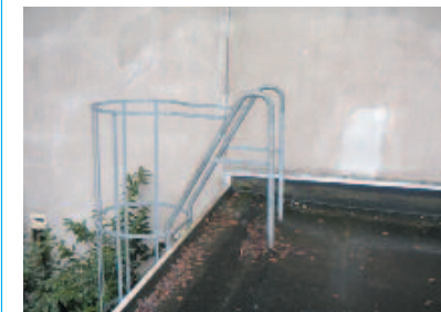
Bild 3-9: Steigleiter mit verlängerten Holmen zur Vorgabe der Gehrichtung
