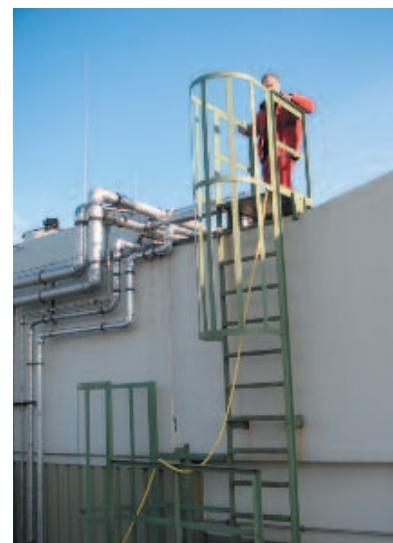
Bild 3-6: Steigleiter als Zugang (nur für gelegentliche Arbeiten)
