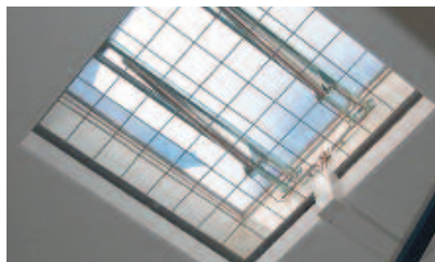
Bild 3-20: Unterspannung einer Lichtkuppel
