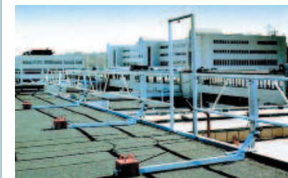
Bild 3-29: Temporäre Geländer, Beispiel 1
