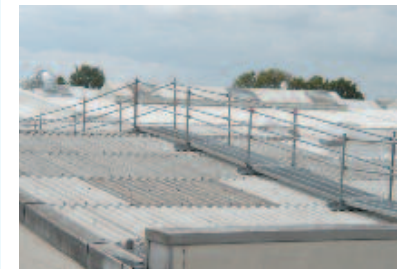
Bild 3-17: Laufsteg über Faserzement-Wellplatten
