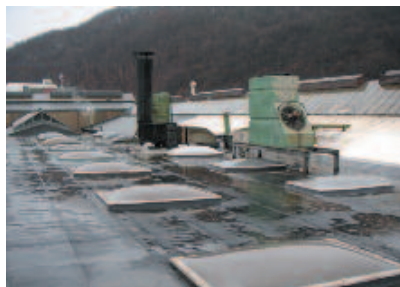
Bild 2-2: Nicht durchsturz sichere Lichtkuppeln im Bereich wartungsbedürftiger Anlagen
