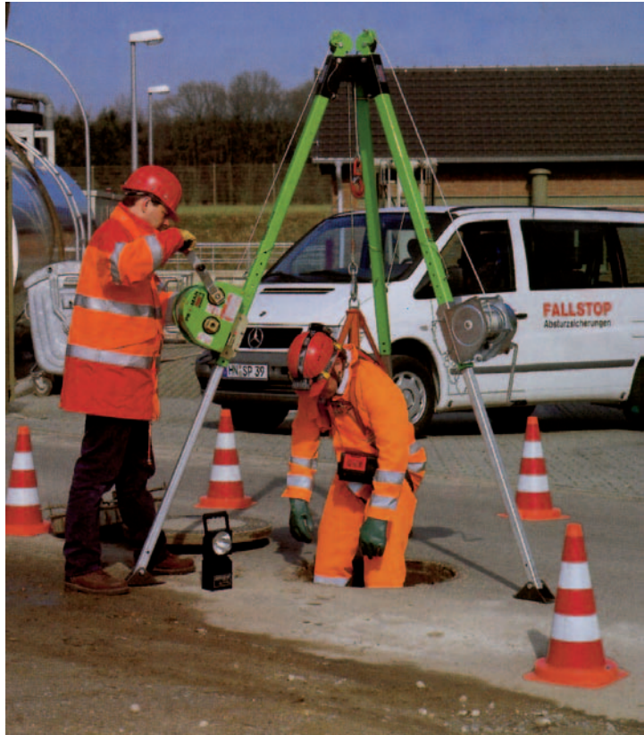
Bild 18: Rettung aus einem Schacht
