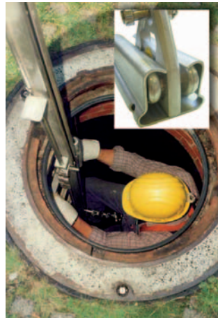
Bild 9: Steigleiter mit Mittelholm, Steigschutzeinrichtung und steckbarer Haltevorrichtung
