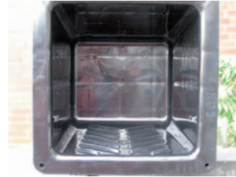
Bild 7: Steigkasten ohne Festhaltungsmöglichkeit
