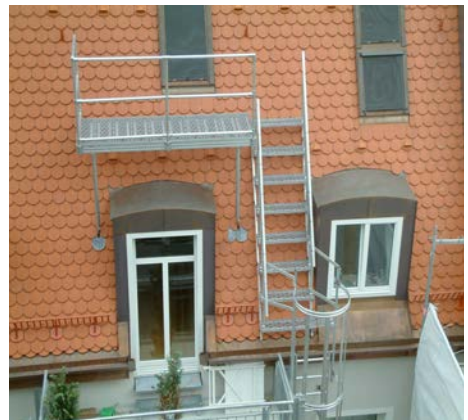
Abb. 15: Komplette Notleiteranlage
