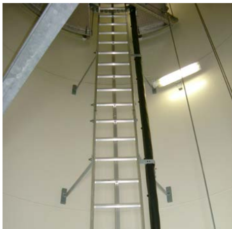
Abb. 21 Steigleiter in einer Windenergieanlage
