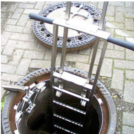
Abb. 16: Einhängbare Schachtsteigleiter kombiniert mit angespannter Haltevorrichtung
