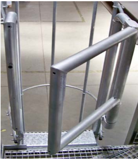
Abb. 22 Ausgleichsstufe aus Riffelblech zur Spaltverkleinerung
