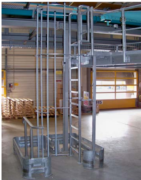
Abb. 20 Steigleiter als Zugang zu einer Maschinenarbeitsbühne
