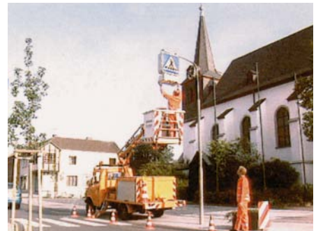
Lampenwechsel an der Beleuchtung eines Fußgängerüberweges
