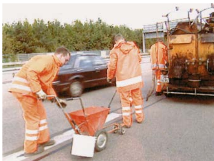
Fugenvergussarbeiten unter Verkehr
