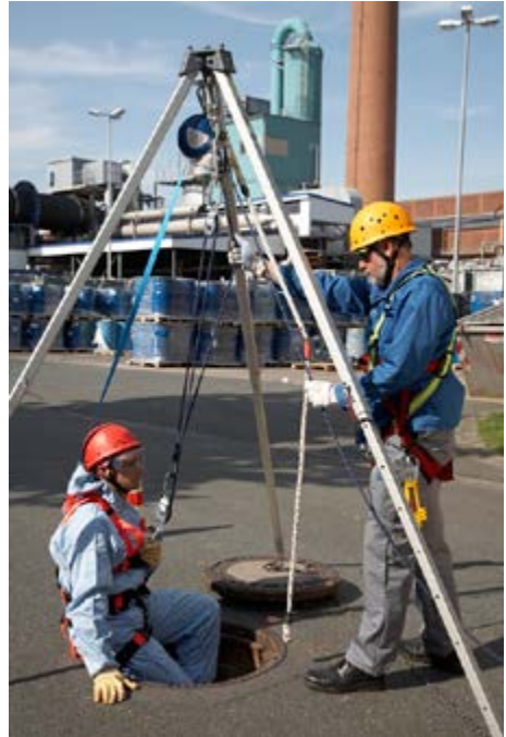
Abb. 23 Rettungshubgerät mit zusätzlichem Höhensicherungsgerät als Schutz gegen Absturz
