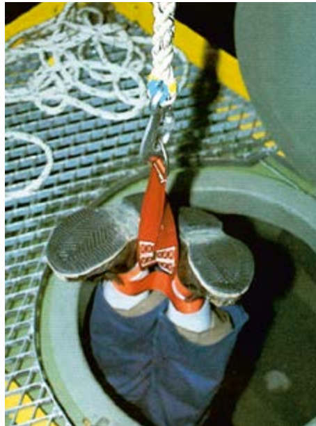
Abb. 28 Rettungsschleife (besonders geeignet zum schnellen Retten)
