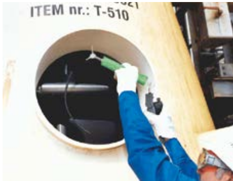
Abb. 20 Probenahme mittels Gassammelrohr
