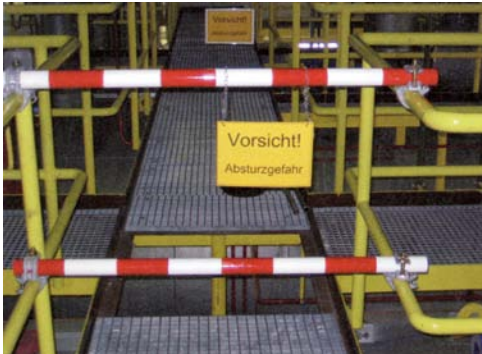
Bild 14: Gesicherte Absturzstelle
