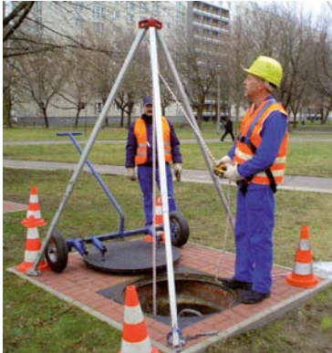
Bild 11: Dreibock mit Hebeeinrichtung
