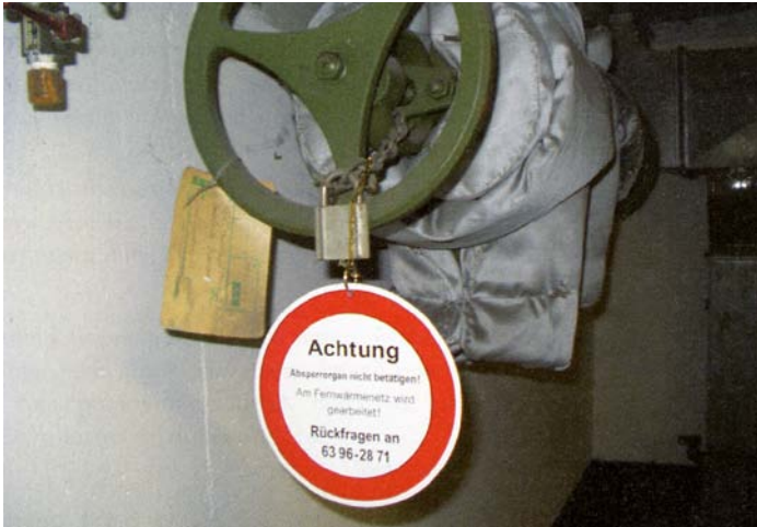
Bild 22: Gesicherte Armatur
