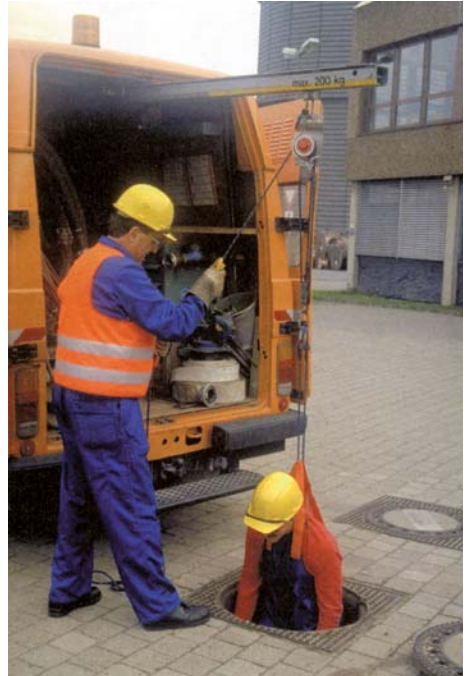
Bild 12: Kragarm mit Hebeeinrichtung
