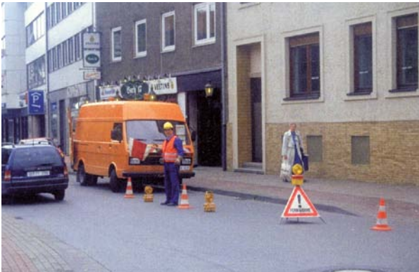
Bild 7: Sicherung von Einsteig- öffnungen im öffentli- chen Straßenverkehr
