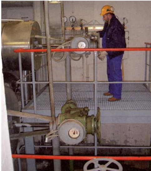
Bild 9: Fest angebrachte Bühne zum sicheren Bedienen und zur Instandhaltung
