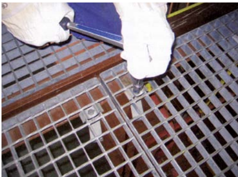
Bild 15: Gesicherte Gitterroste
