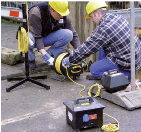
Bild 17: Schutztrennung und Schutzkleinspannung
