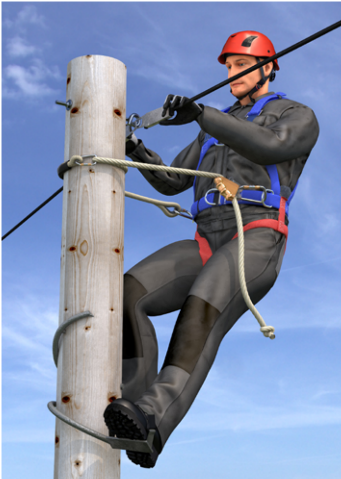
Abb. 13 Beispiel für die Benutzung eines Arbeitsplatzpositionierungssystems an einem Holzmast (Auffanggurt mit Halteösen und Halteseil)
