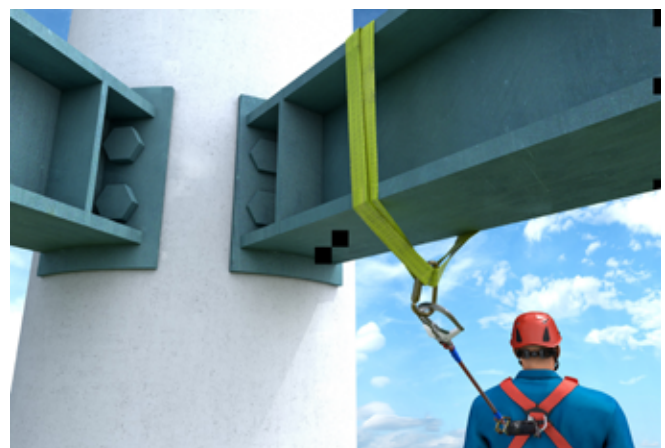
Abb. 58 Beispiel einer temporär genutzten Anschlagmöglichkeit (Stahlträger)
