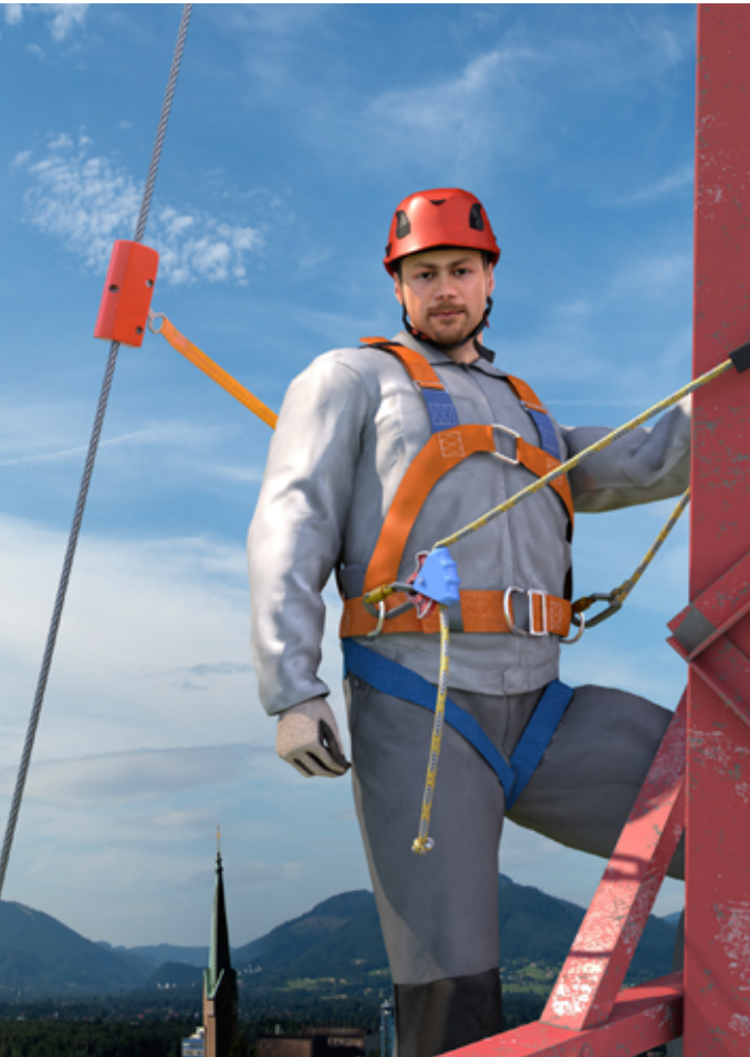
Abb. 15 Beispiel für die Benutzung eines Arbeitsplatzpositionierungssystems an einem Stahlgittermast (Auffanggurt mit Halteösen und Halteseil) mit zusätzlichem Auffangsystem als Schutz gegen Absturz während der Fortbewegung am Mast
