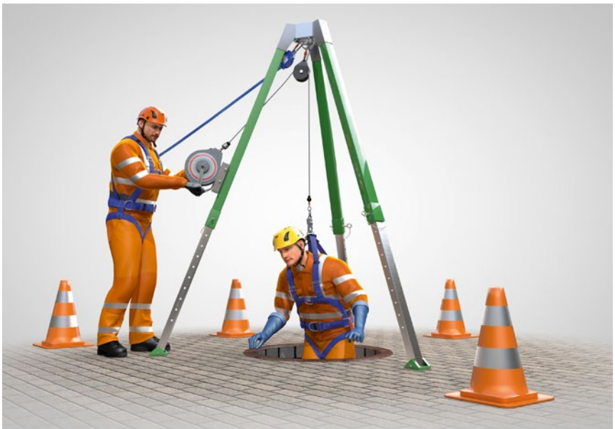
Abb. 2 Rettung aus einem Kanalschacht (Quelle: „Baustein A005“ der BG BAU)
