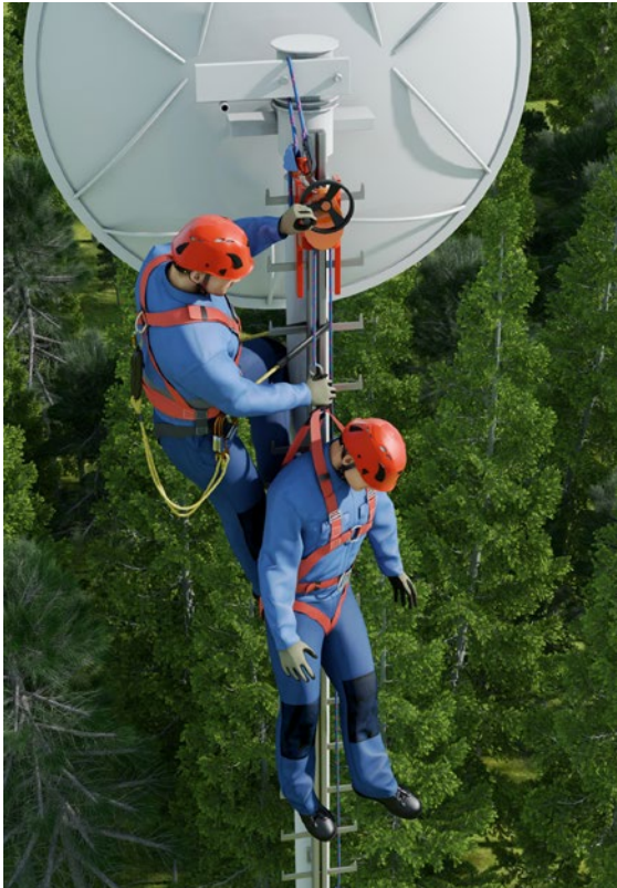
Abb. 16 Abseilgerät mit integrierter Hubeinrichtung (Passivrettung)
