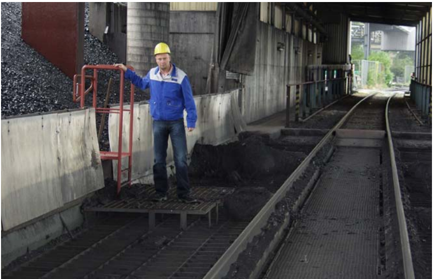
Abb. 12.1.1.3 Beispiel für eine feste Bedienplattform an einem Kohlebunker, die ein Betreten der Bunkerroste weitgehend entbehrlieh macht.
