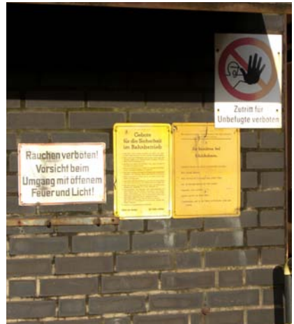
Abb. 12.1.1.2 Eingehauste Kohlentladeanlage mit Sicherheitskennzeichnung
