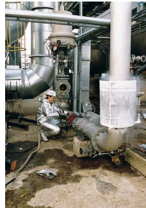
Abb. 7.2 Beispiel für den Einsatz eines Frostverfahrens
