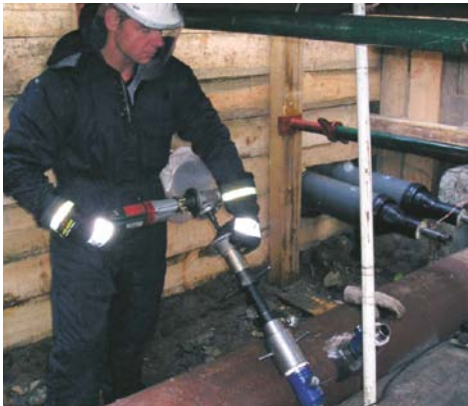
Abb. 7.1 Beispiel für den Einsatz eines Anbohrverfahrens
