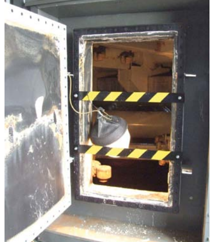
Abb. 8.1.5 Hinter der geöffneten Einstiegs Luke besteht Absturzgefahr. Daher ist die Absturzstelle mit festen Absperren gesichert.
