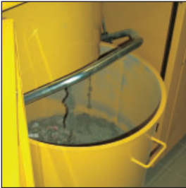
Abb. 16: Staubbehälter eines Zentralstaubsaugers
