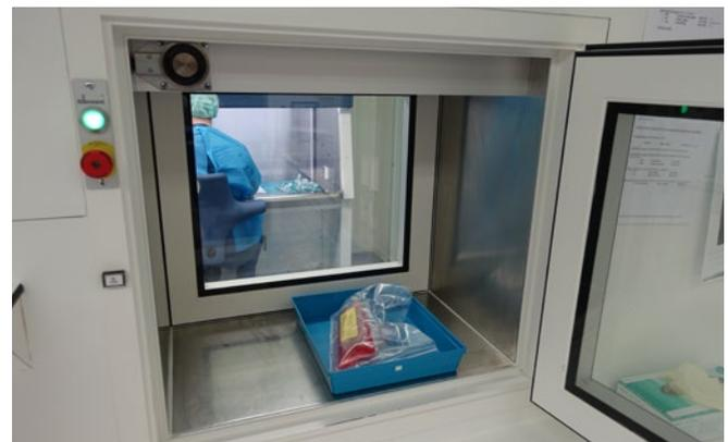
Abb. 10 Ausschleusen fertiger Zubereitungen
