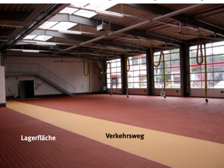
Bild 8 Farbliche Absetzung des Verkehrsweges in der Fahrzeughalle
