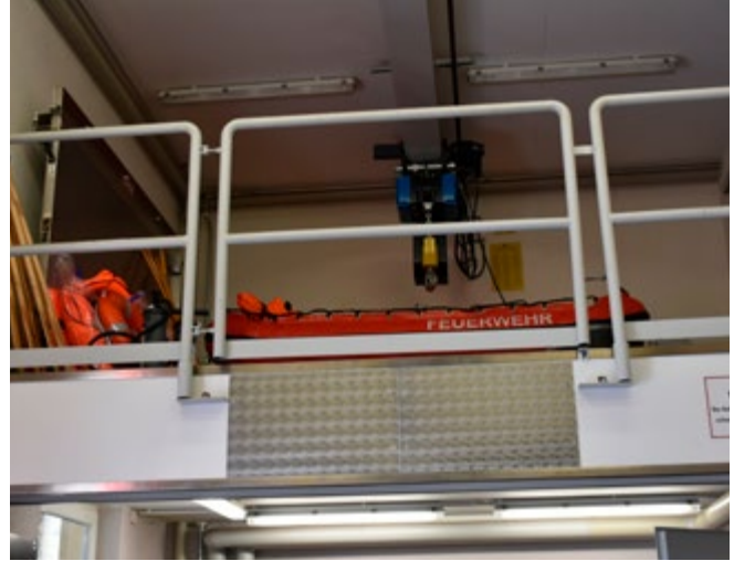
Bild 43 Zwischenboden (Fußleiste, Steckgeländer)
