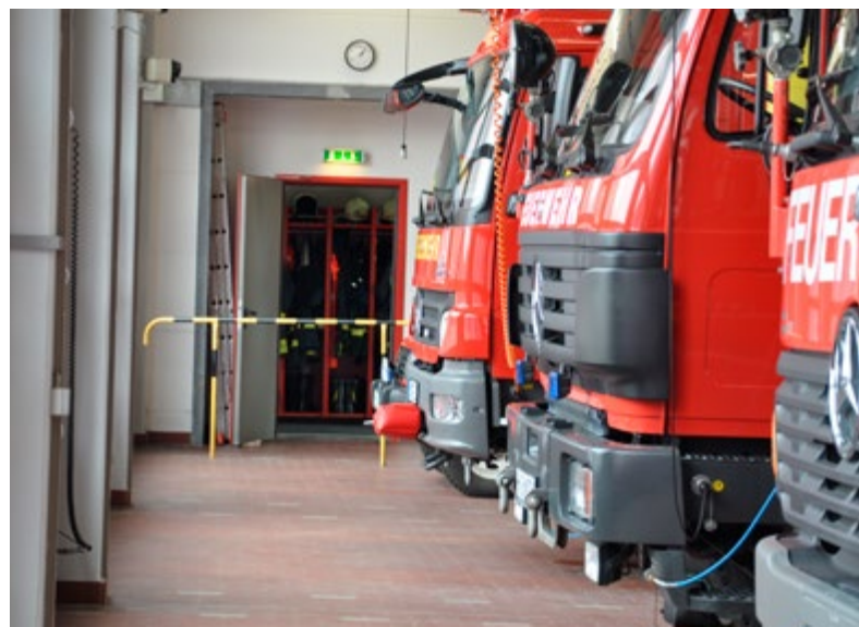
Bild 7 Geländer im Zugang zur Fahrzeughalle
