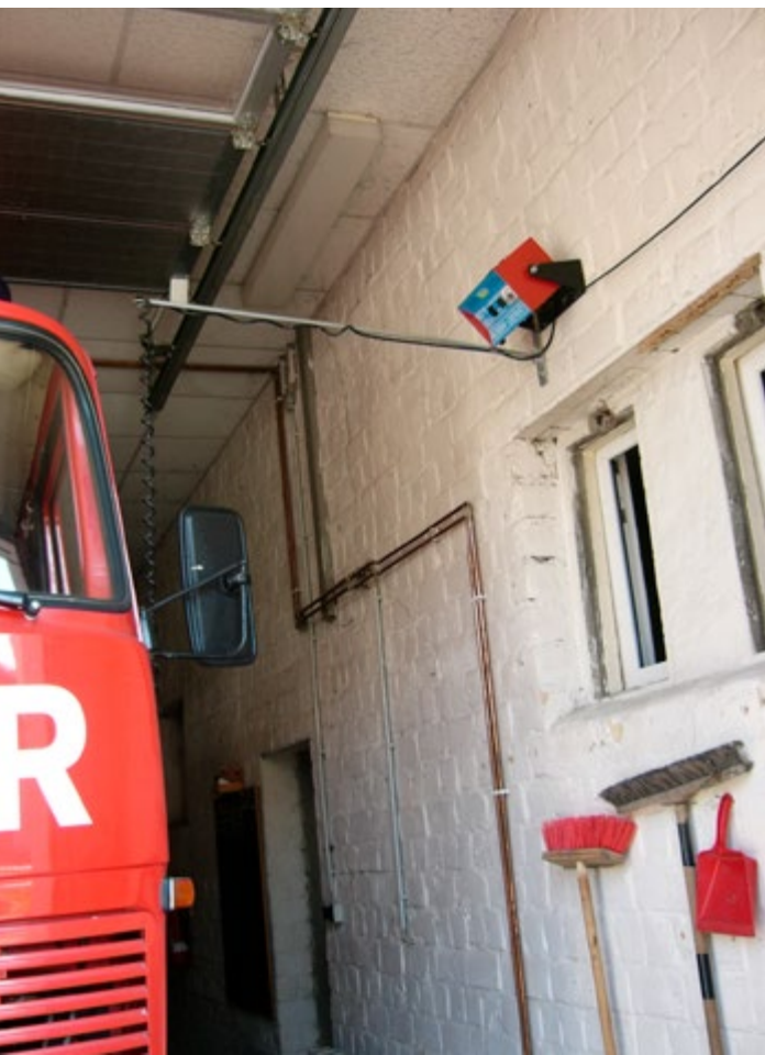
Bild 12 Über Galgen verlegtes Kabel
