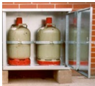
Bild 44 Kleinlager für Flüssiggasflaschen im Freien
