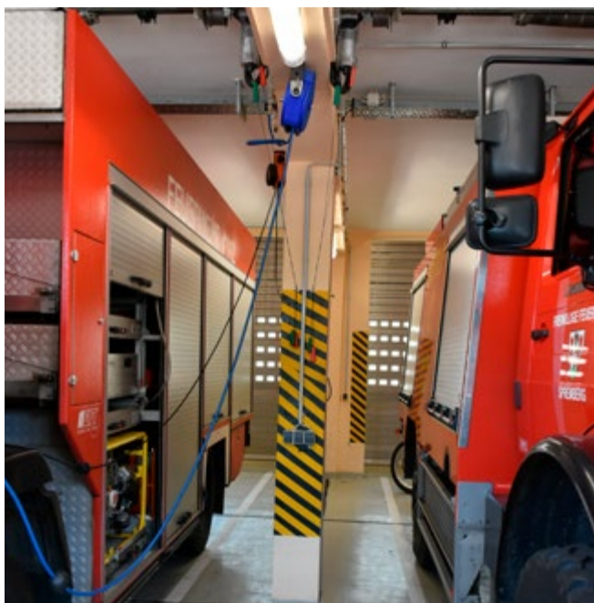
Bild 20 Als Übergangslösung: Markierung der einengenden Gebäudeteile
