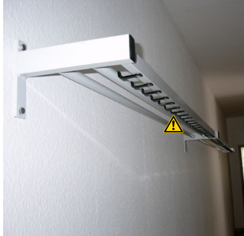
Bild 9 Garderobenhaken in Augenhöhe bilden Verletzungsgefahren
