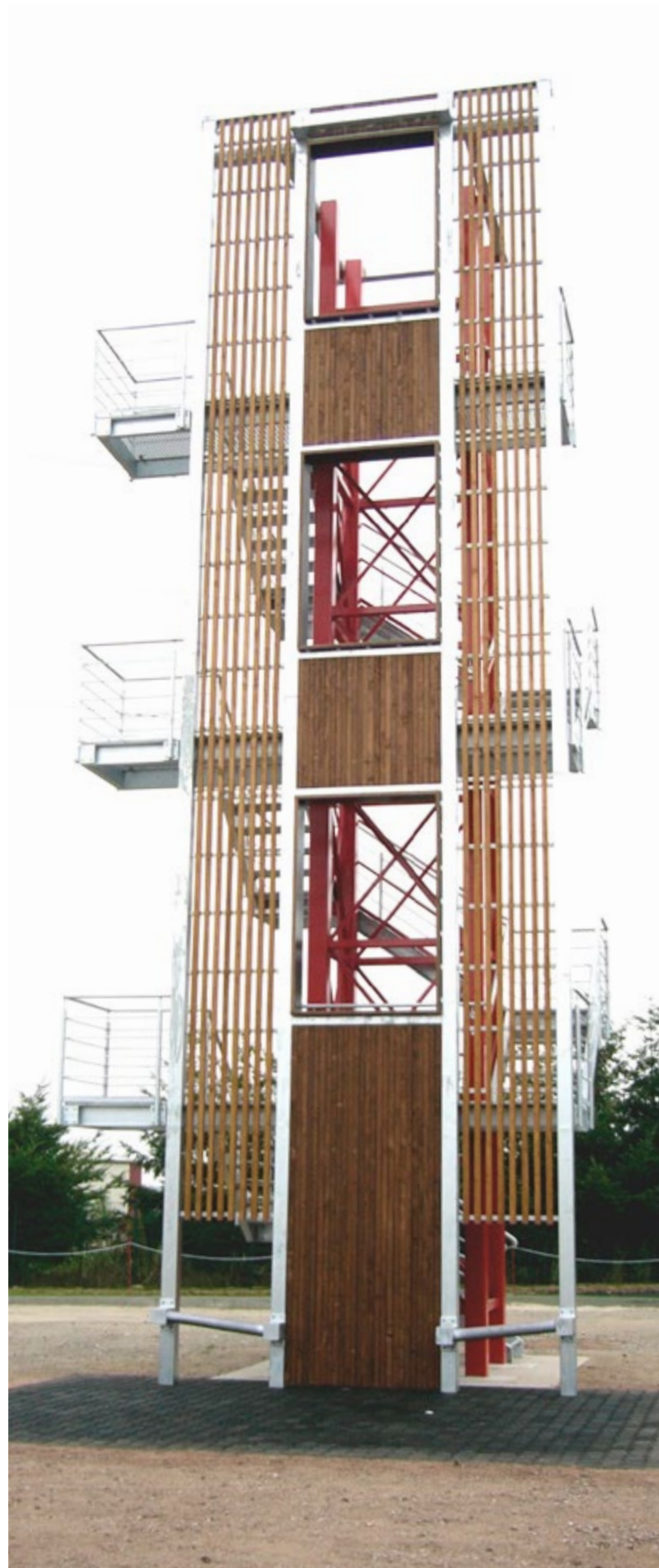
Bild 51 Übungsturm mit davor angeordnetem stoßdämpfendem Boden
