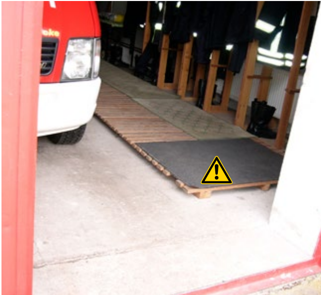
Bild 17 Diese Konstruktion birgt Umknick- oder Stolpergefahr
