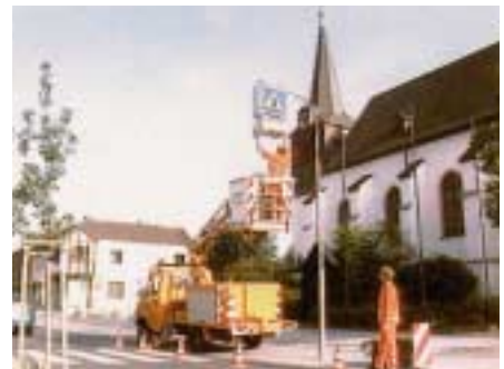
Lampenwechsel an der Beleuchtung eines Fußgängerüberweges
