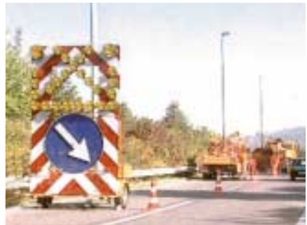
Sicherung einer Arbeitsstelle auf einer Bundesautobahn
