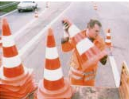
Absperren des Arbeitsbereiches mit Leitkegeln
