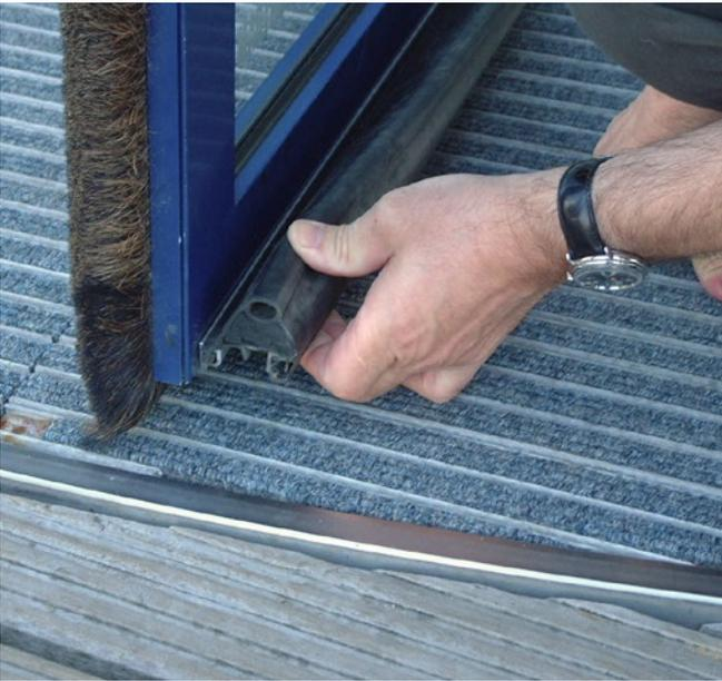
**Abb. 9** Defekte Kontaktleistenbefestigung
