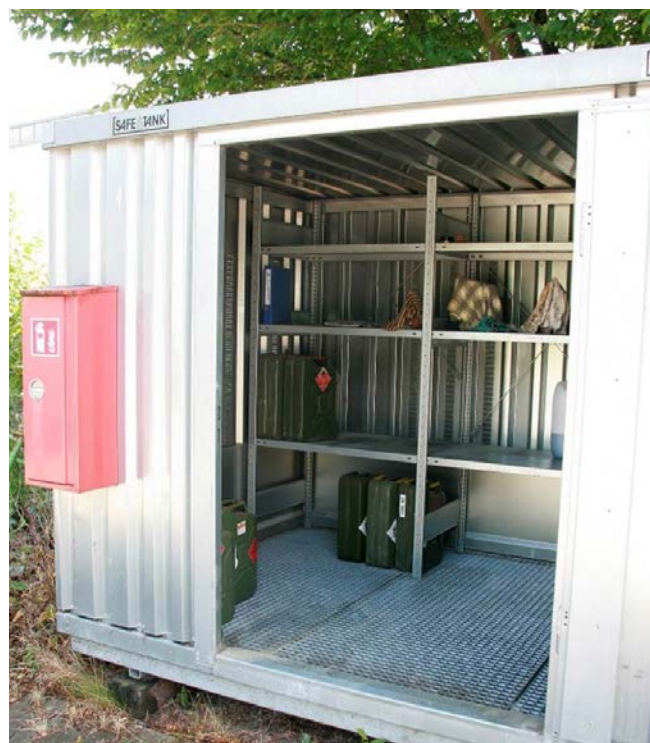
Abb. 8 Vorschriftenkonforme Lagerung von Gefahrstoffen
