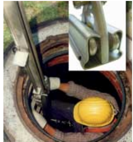
Bild 9: Steigleiter mit Mittelholm, Steigschutzeinrichtung und steckbarer Haltevorrichtung
