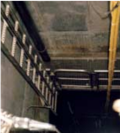
Bild 8: Steigleiter mit Seitenholmen, Steigschutzeinrichtung und Podest
