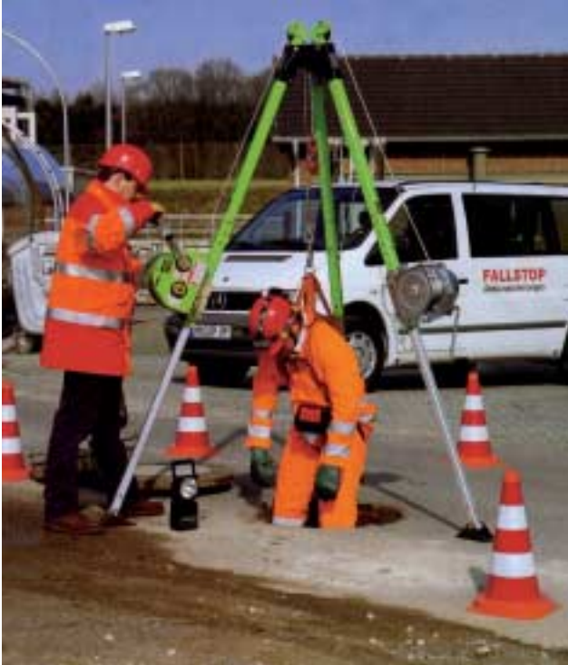
Bild 18: Rettung aus einem Schacht
