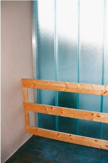
**Abb. 8** Abschirmung einer Wand aus Profilbauglas
