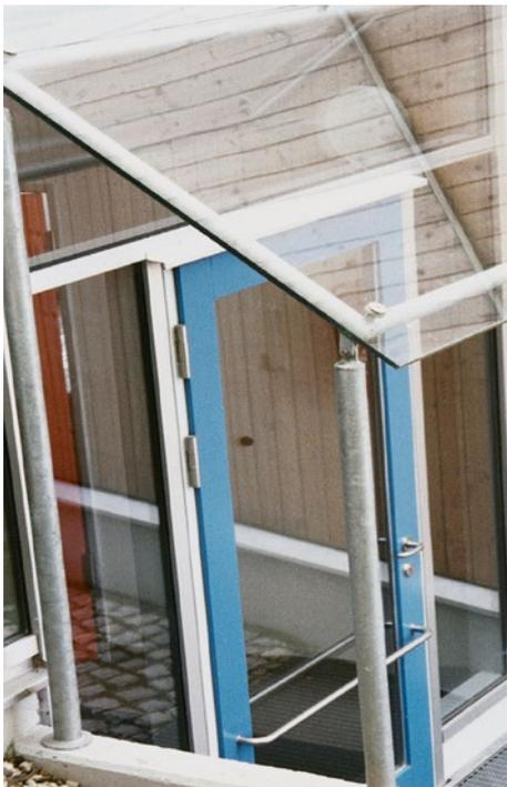
Abb. 5 Überkopfverglasung aus VSG
