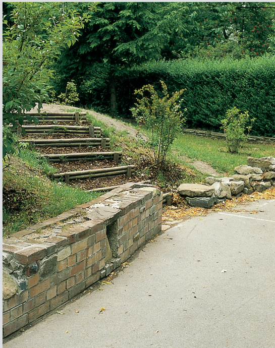
Geeigneter Aufstieg durch Holzbohlen und Rindenmulch, jedoch scharfkantige Mauerbereiche
