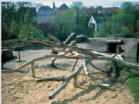
Aus Baumteilen konstruierte Spielmöglichkeit (mechanische Dauerfestigkeit ist fraglich und Sturz auf tiefer liegende Holzteile möglich)
