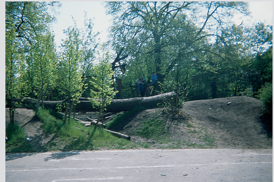
Stoßdämpfender Untergrund unter „Brücke“ mangelhaft (Baumstämme)
