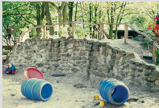
Natursteinwand mit Handlauf als Absturzsicherung
