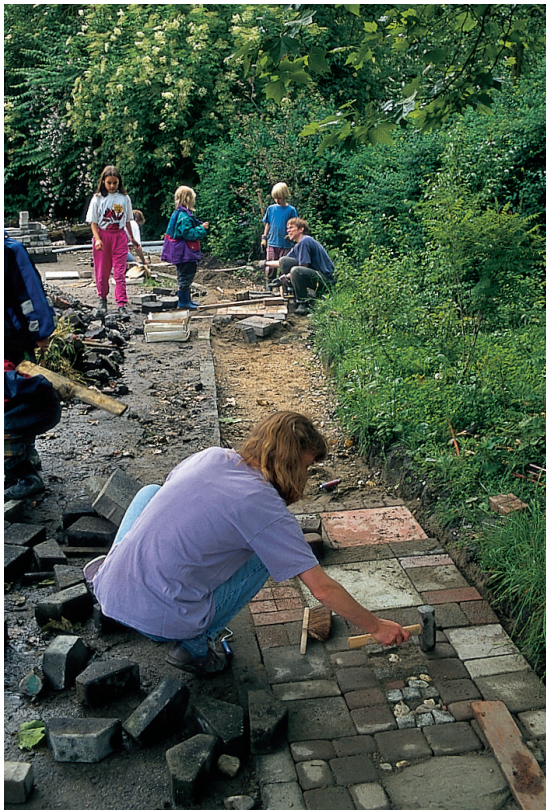
Eine Pflasterspur entsteht.
