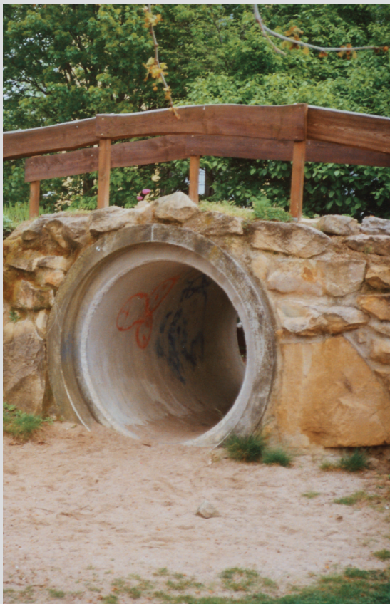
Natursteinmaterial sicher verlegt, ausreichender Durchmesser der Spielröhre
