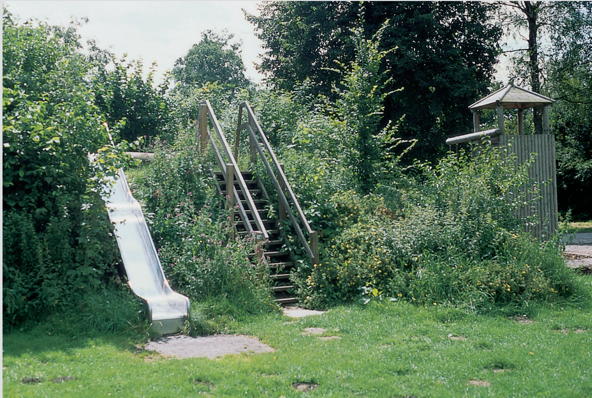
Ausreichend befestigte Rutsche (DIN EN 1176), ungeeigneter Auslaufbereich
