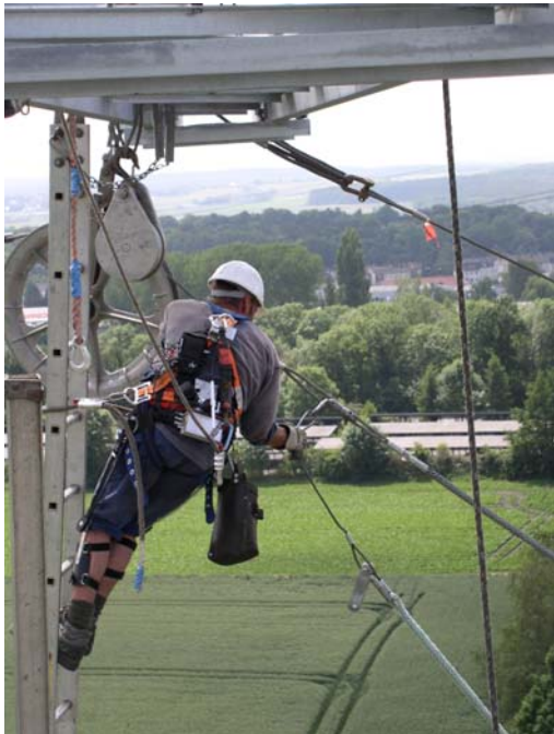
Abbildung 2-31: Messungen bei Arbeiten an Freileitungen
