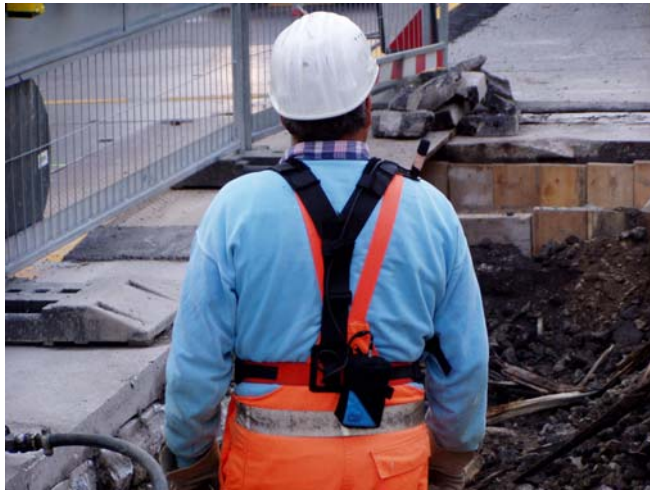
Abbildung 2-25: Gurtsystem zur Fixierung des Mikrofons bei Lärmdosimeter-Messungen
