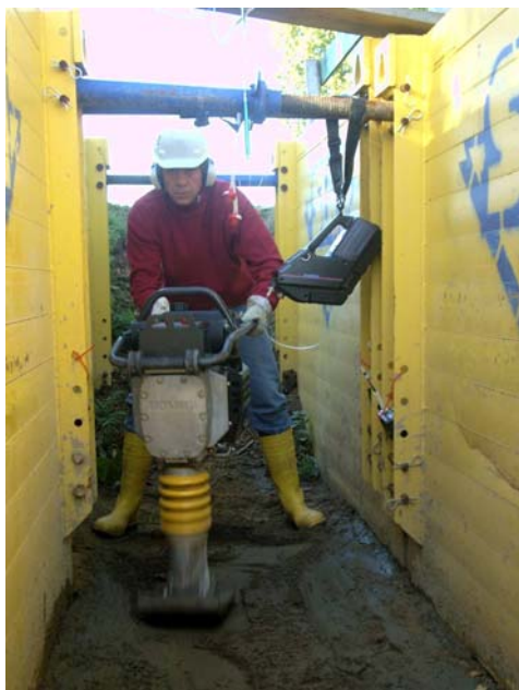
Abbildung 2-10: Abgasmessungen in Gräben
