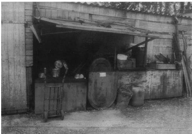
Abbildung 2-15: Arbeitsplatz zur Kfz-Teile-Reinigung mit Vergaserkraftstoff
