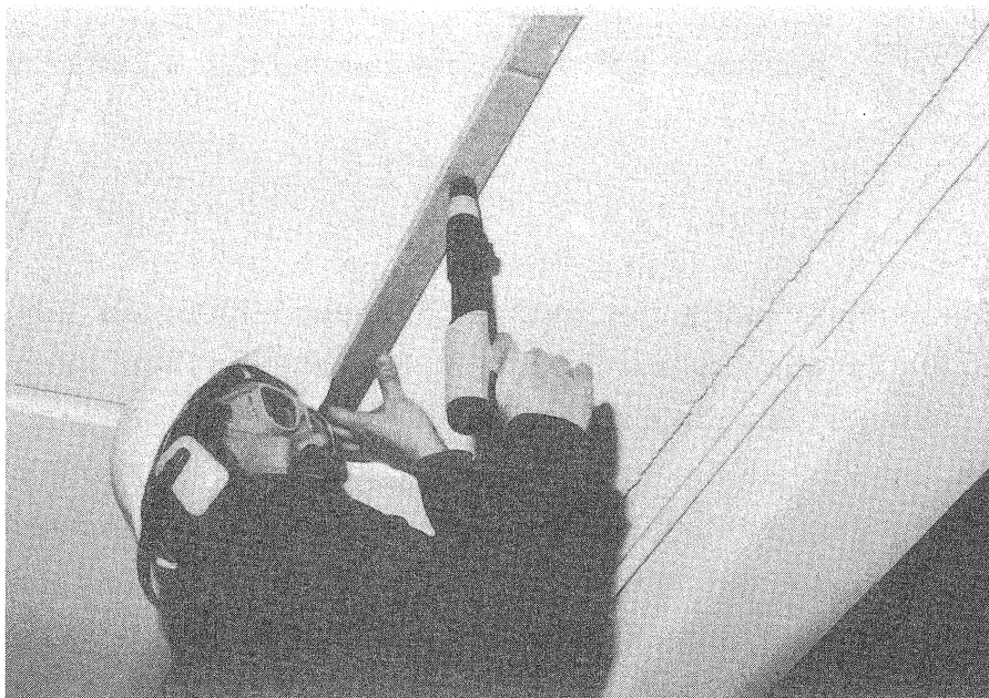
Abbildung 9 : Arbeitsplatz mit Bolzensetzwerkzeug zur Befestigung von Holzlatten an der Decke
