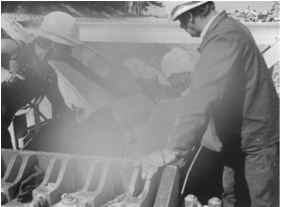
Abbildung 25: Manuelle Aussortierung beim Baustoffrecycling
