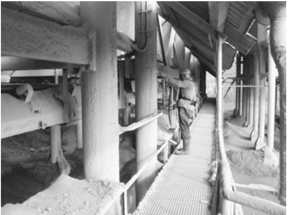
Abbildung 22: Kontrollgang im Bereich der Schotterumladung
