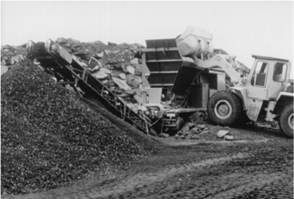
Abbildung 26: Brecherbeschickung beim Baustoffrecycling
