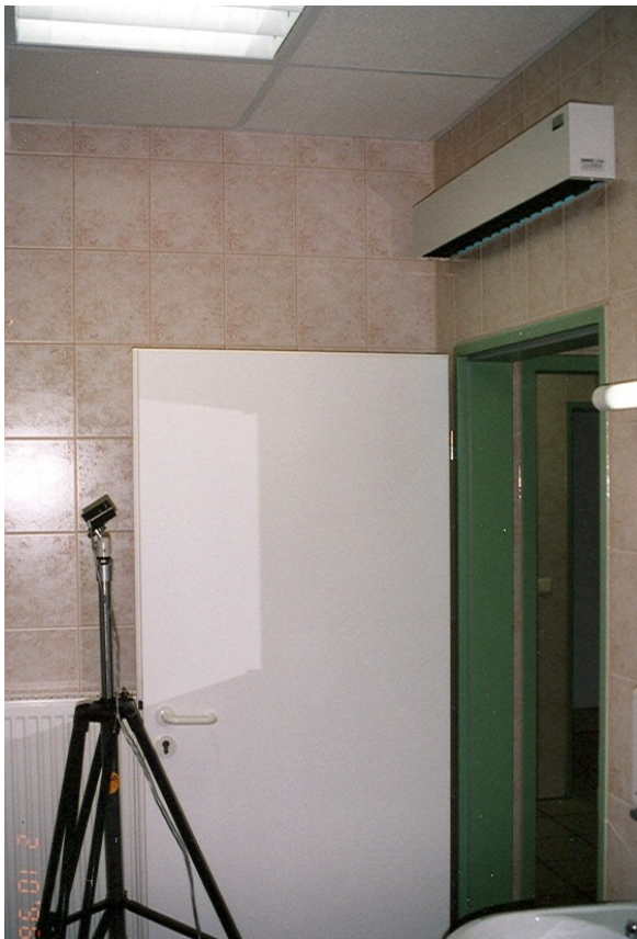
Abbildung 12: UV-Entkeimungslampe über der Tür in einer Wertstoffsortieranlage
