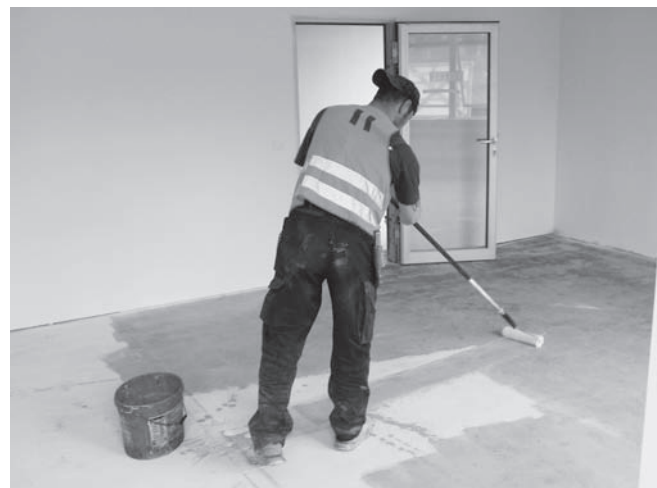
Abbildung C.21: Grundierung mit Rolle auftragen
