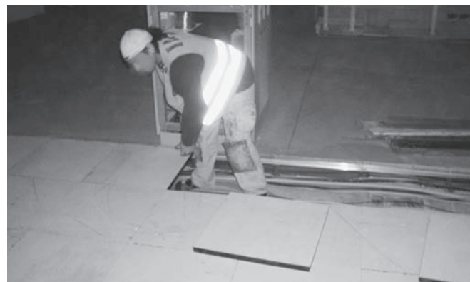
Abbildung C.23: Bodenplatten ausheben
