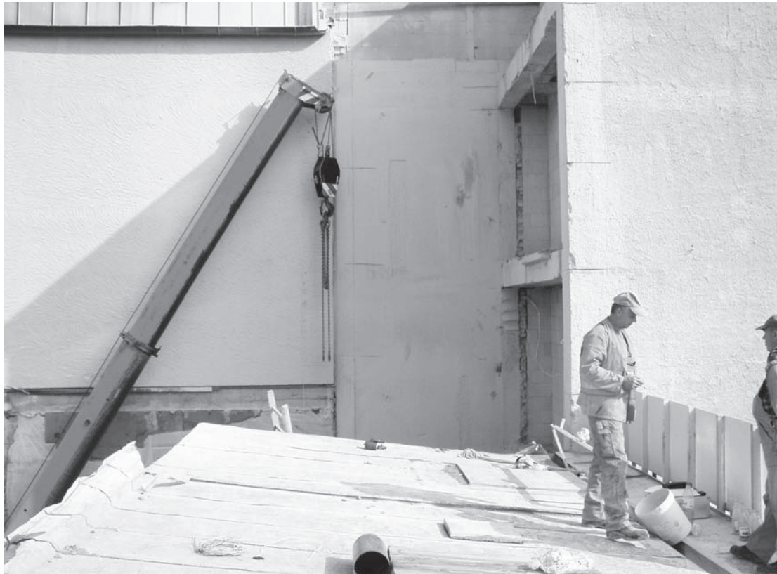
Abbildung D.1: Baustelle 1
