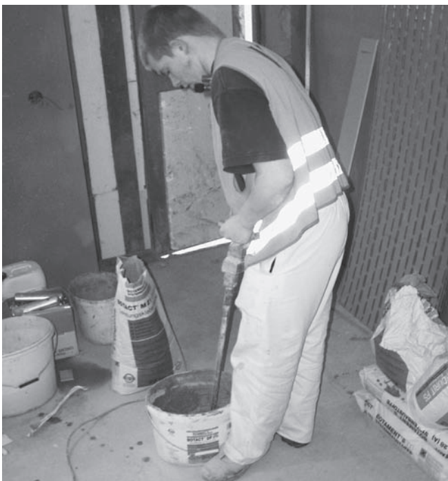
Abbildung A.19: Fliesenkleber anmischen
