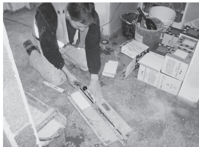
Abbildung A.14: Fliese mit Fliesenbrett schneiden
