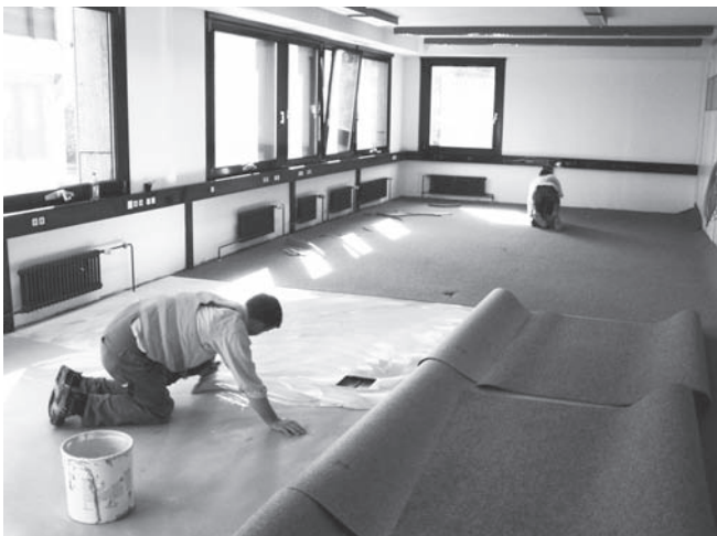
Abbildung C.17: Kleber auftragen
