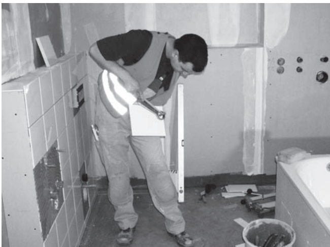
Abbildung A.25: Wandfliese mit Fliesenhammer bearbeiten
