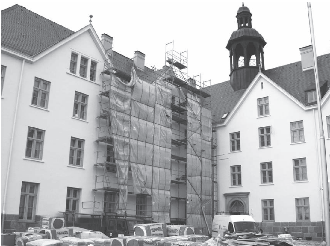
Abbildung B.3: Baustelle 5
