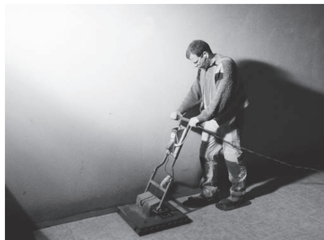
Abbildung A.30: Fliesen mit Rollenrüttler abrütteln
