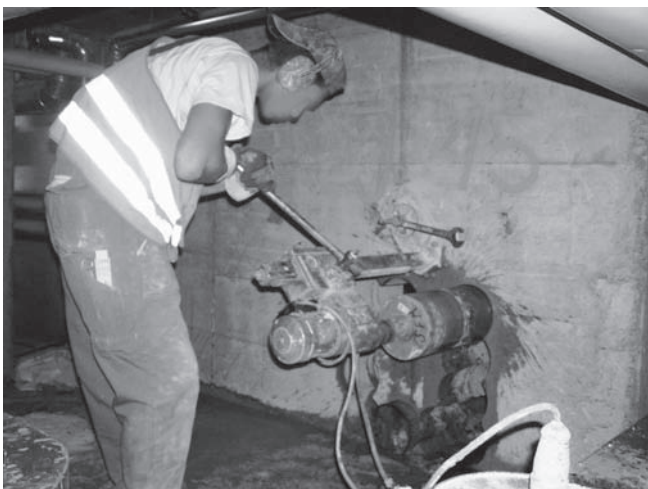
Abbildung D.14: Kernbohrgeräte bedienen
