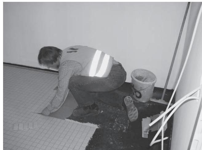
Abbildung A.16: Fliesen verlegen
