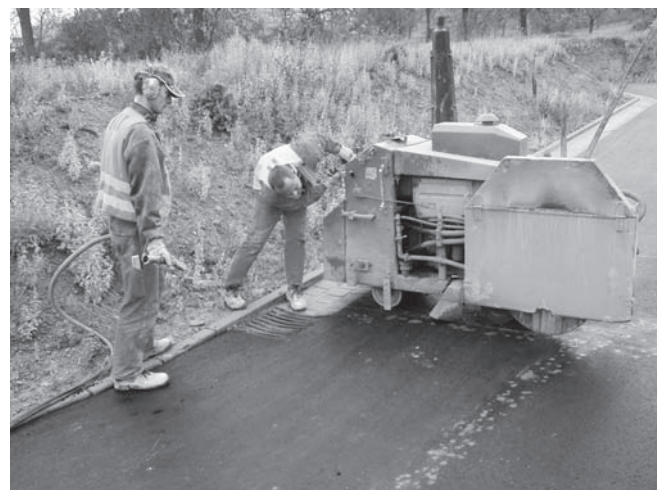
Abbildung D.20: Fugenschneider bedienen
