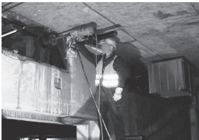
Abbildung D.26: Kernbohrung durchführen
