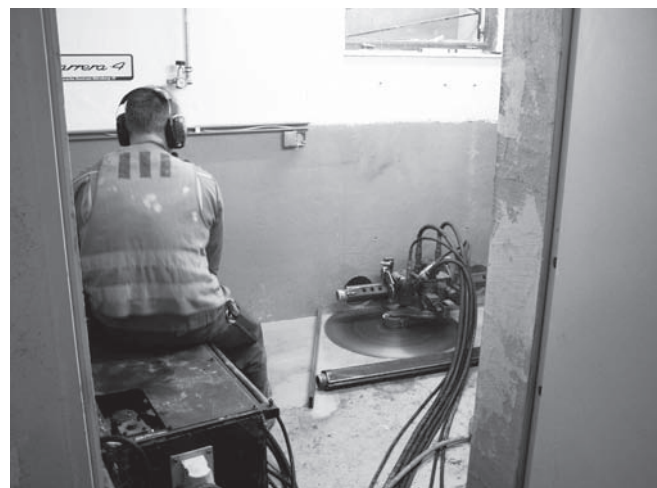
Abbildung D.28: Betonsäge bedienen
