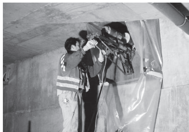
Abbildung D.24: Kernbohrgerät bedienen
