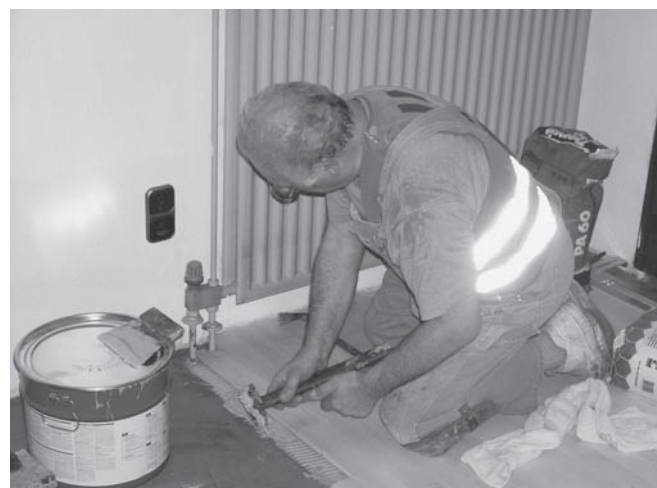
Abbildung B.7: Parkett verlegen
