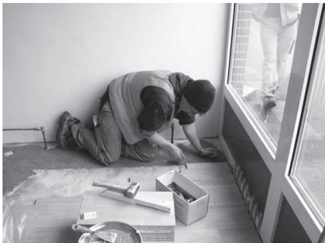
Abbildung B.10: Parkett verlegen
