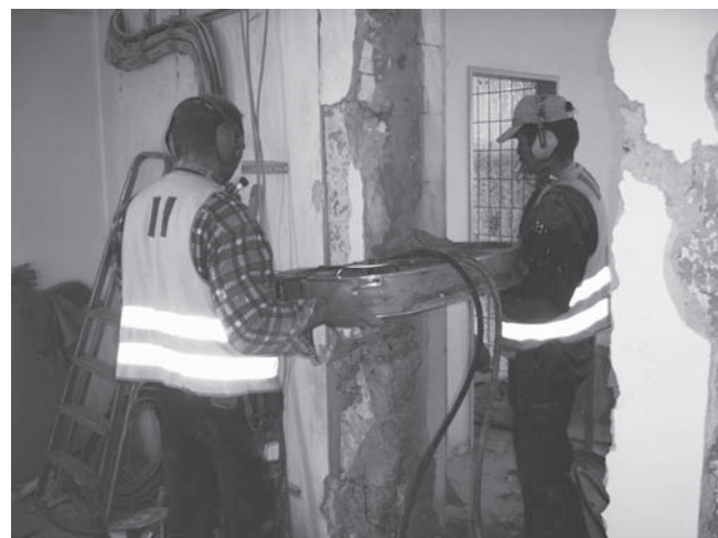
Abbildung D.30: Abbruch einer Betonwand mit Hydraulikzange
