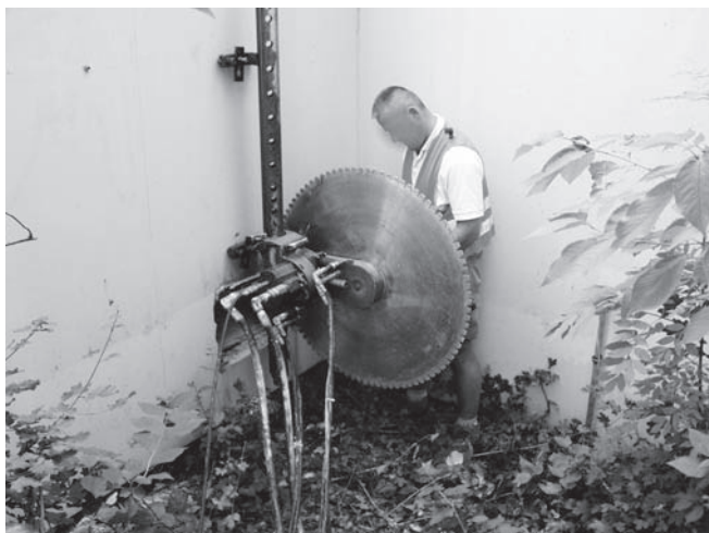
Abbildung D.12: Wandsäge montieren
