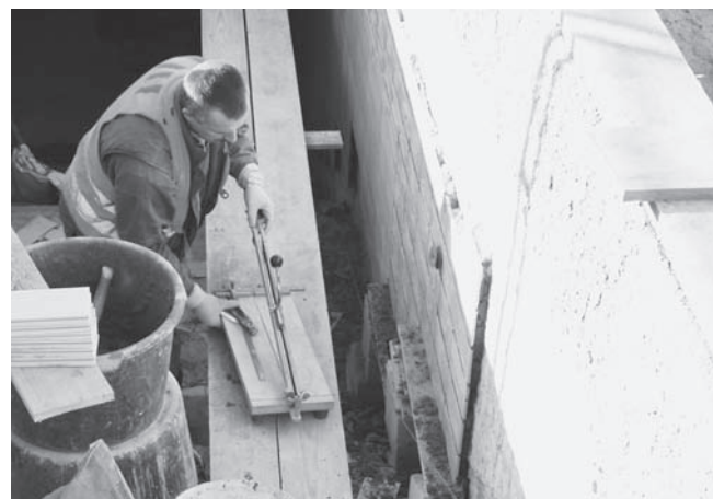
Abbildung A.12: Fliesen schneiden
