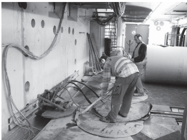
Abbildung D.18: Wasser mit Industriesauger absaugen
