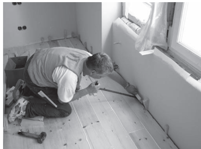
Abbildung B.14: Parkettböden verlegen
