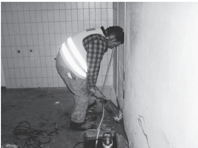
Abbildung D.31: Kernbohrung durch Mauerwerk
