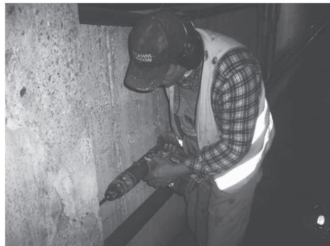
Abbildung D.32: Bolzenlöcher in Betonwand bohren
