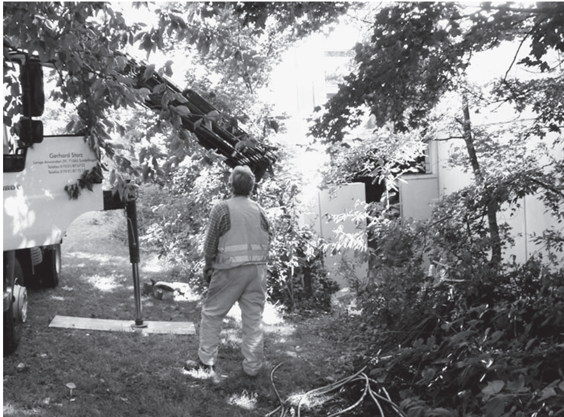
Abbildung D.2: Baustelle 2
