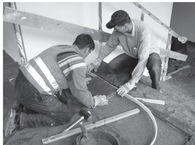
Abbildung A.40: Bodenplatten verlegen
