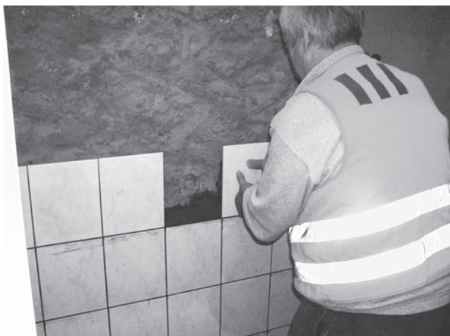
Abbildung A.11: Wandfliesen im Dickbettverfahren verlegen
