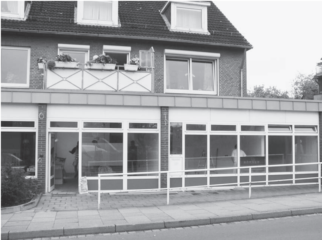
Abbildung B.2: Baustelle 3
