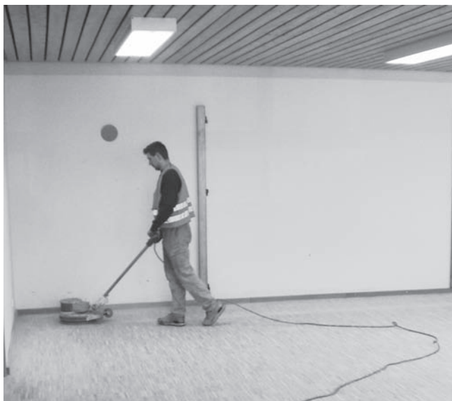
Abbildung B.18: Parkett mit Einscheibengerät fein abschleifen
