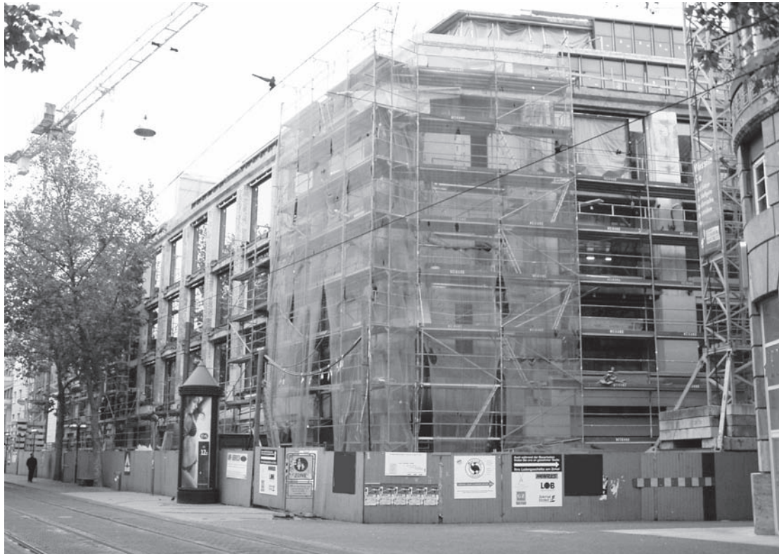
Abbildung D.8: Baustelle 12
