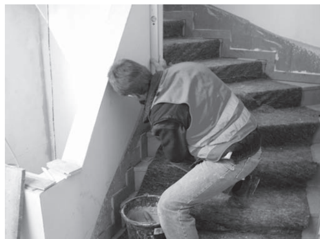
Abbildung A. 39: Treppenabschlusskante kleben
