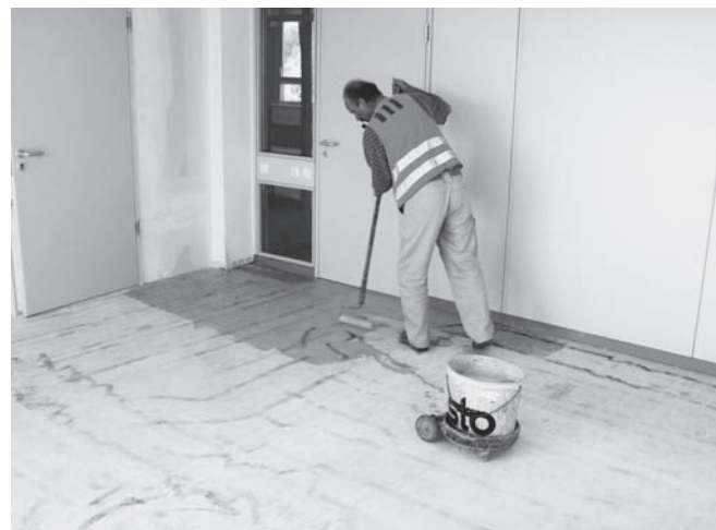
Abbildung C.16: Grundierung mit Rolle auftragen
