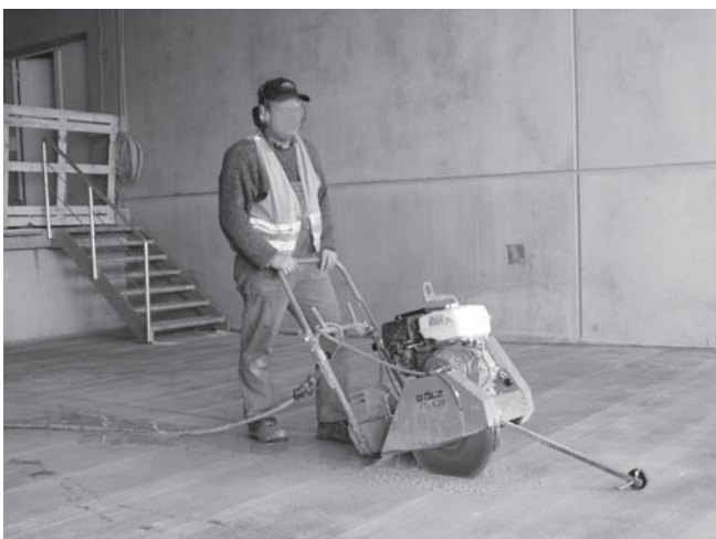
Abbildung D.21: Fugenschneider bedienen
