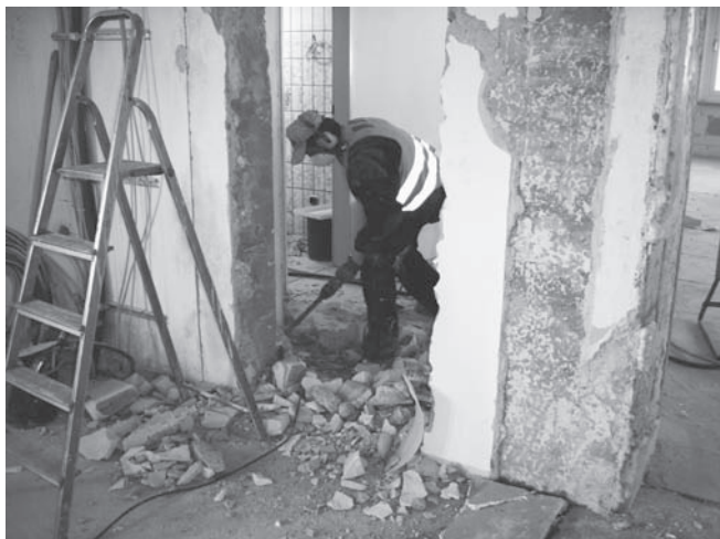
Abbildung D.29: Betonwand mit Stemmgerät einstemmen
