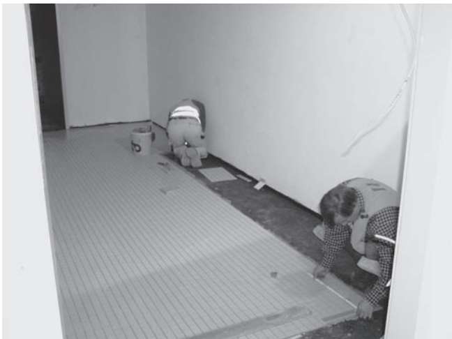
Abbildung A.17: Fliesen verlegen
