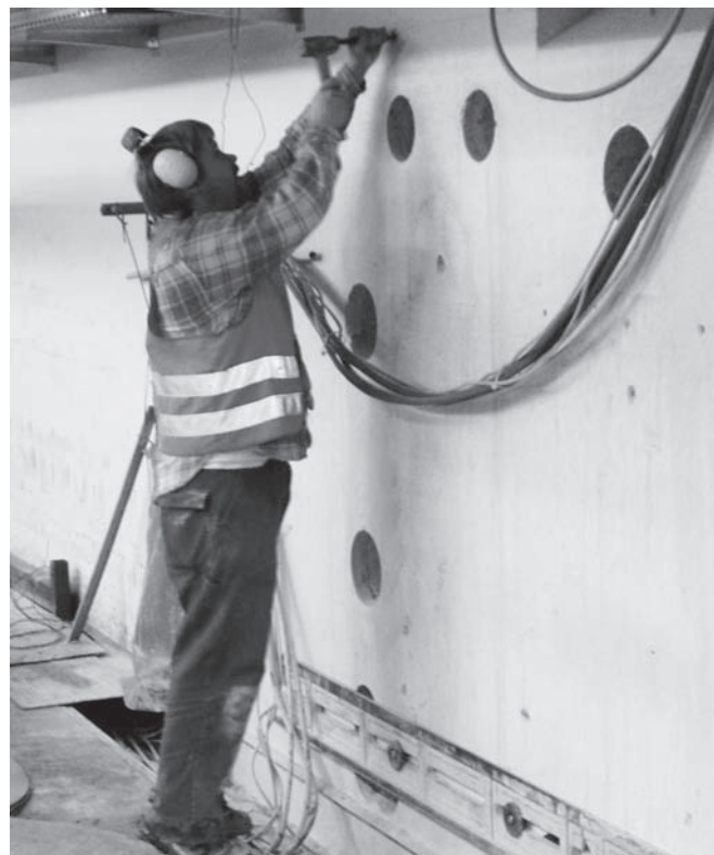
Abbildung D.17: Befestigungsbolzen einschlagen
