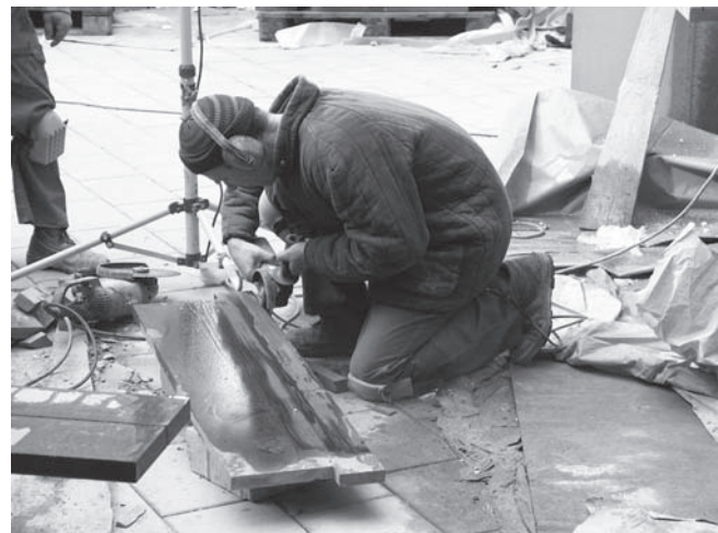
Abbildung A.42: Granitplatten mit Winkel-/Trennschleifer bearbeiten
