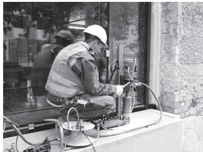
Abbildung D.27: Kernbohrung an der Außenfassade
