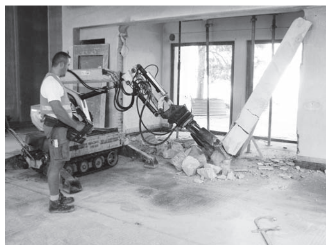
Abbildung D.15: Abbruchbagger fernsteuern
