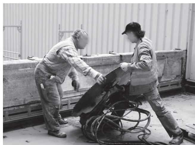
Abbildung D.22: Betonsäge montieren
