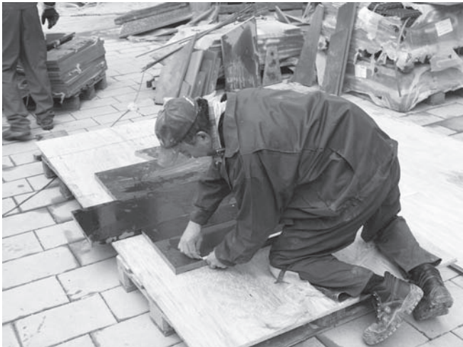
Abbildung A.43: Ausmessen und anzeichnen
