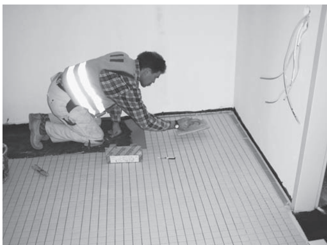
Abbildung A.15: Fliesen ausrichten und festsetzen
