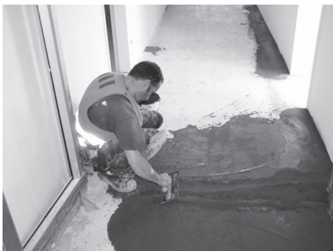
Abbildung C.18: Ausgleichsmasse auftragen
