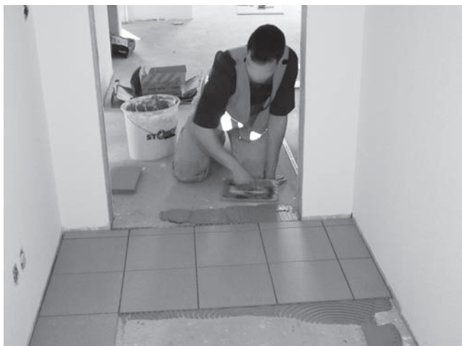
Abbildung A.23: Fliesenkleber auftragen
