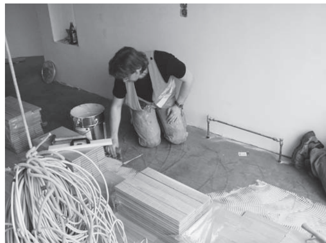
Abbildung B.11: Parkett verlegen
