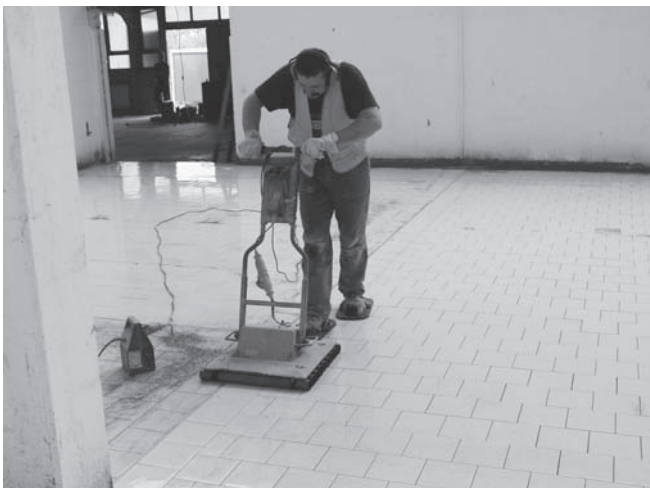
Abbildung A.34: Fliesen mit Rollenrüttler abrütteln
