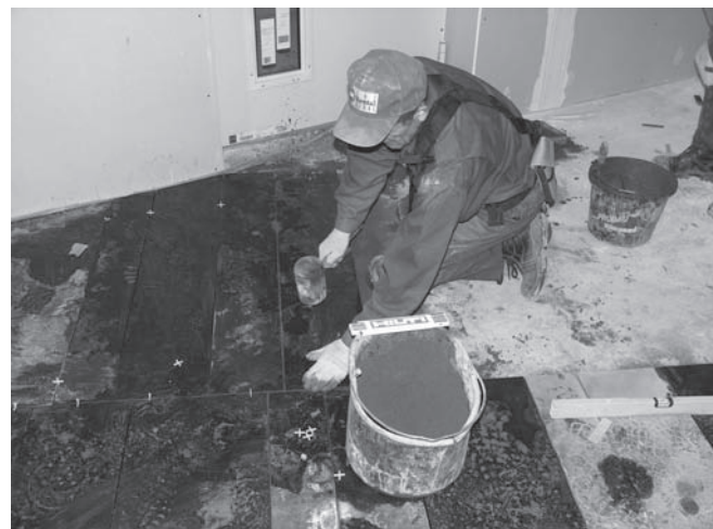
Abbildung A.44: Granitplatten ausrichten
