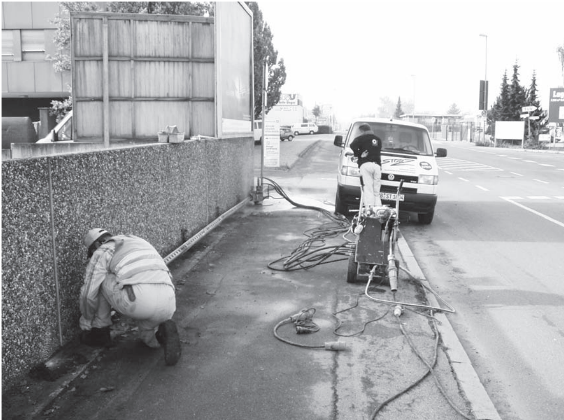
Abbildung D.6: Baustelle 9
