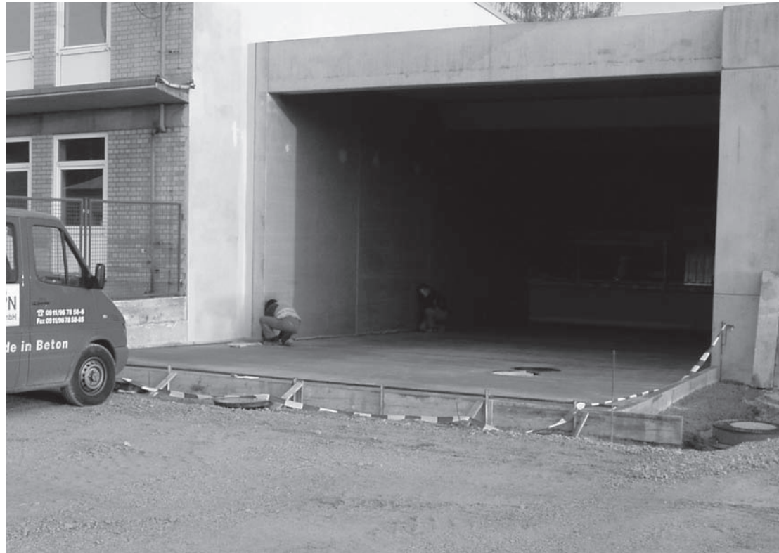
Abbildung D.5: Baustelle 7
