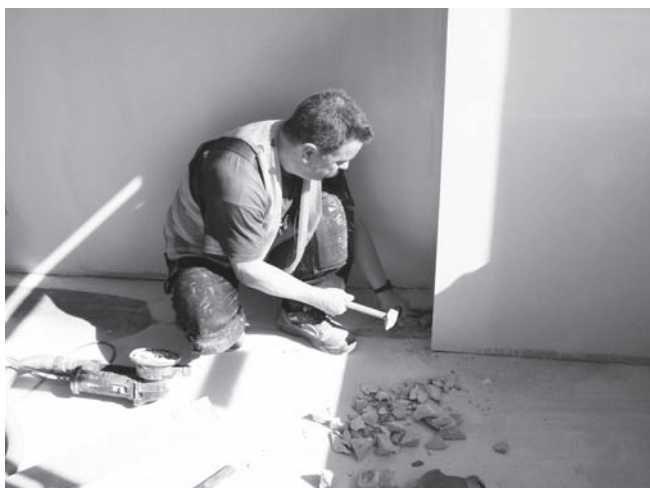
Abbildung C.20: Estrich mit Hammer und Meißel bearbeiten
