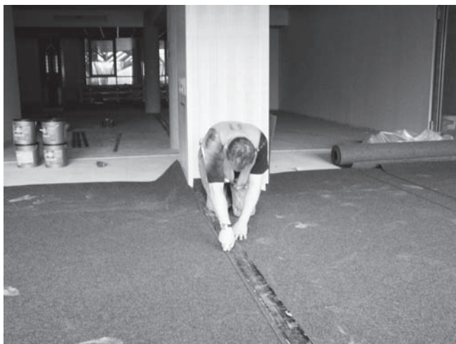
Abbildung C.24: Nadelfilz schneiden
