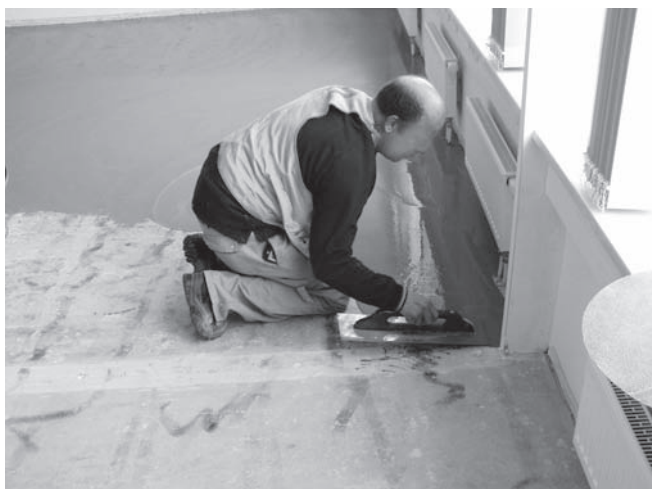
Abbildung C.15: Ausgleichsmasse auftragen
