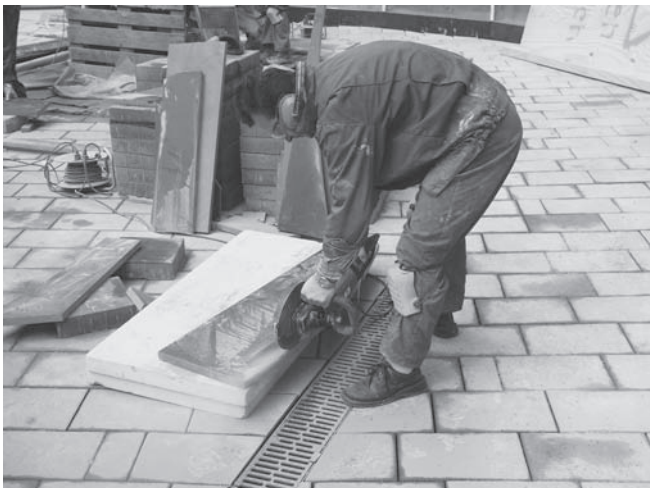
Abbildung A.45: Granitplatte mit Winkel-/Trennschleifer bearbeiten
