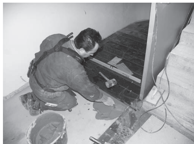
Abbildung A.46: Granitplatte kleben
