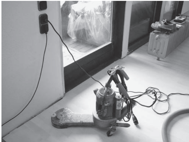
Abbildung B.8: Parkett mit handgeführtem Gerät abschleifen
