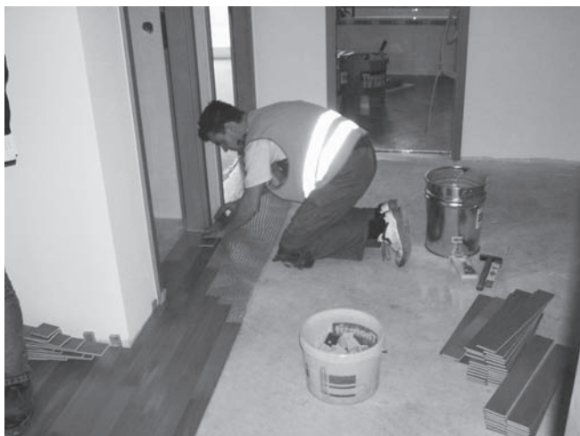
Abbildung B.12: Parkett verlegen
