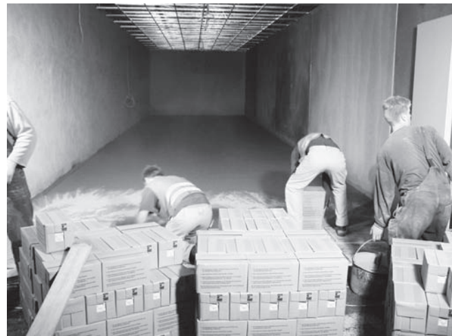
Abbildung A.31: Bodenfliesen verlegen
