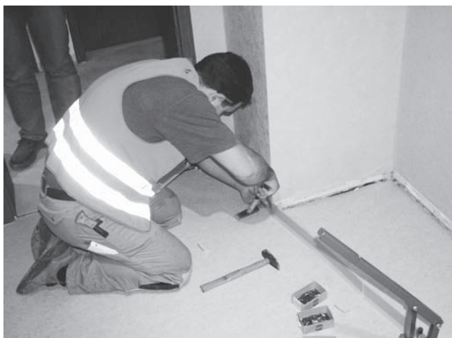
Abbildung C.9: Fußleiste festnageln
