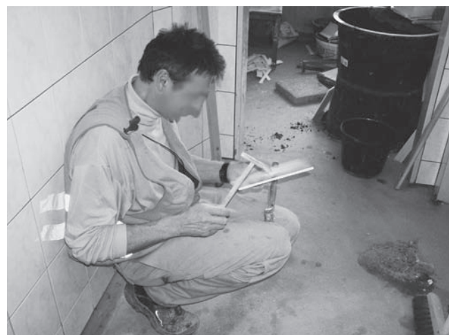
Abbildung A.10: Fliese mit Fliesenhammer bearbeiten
