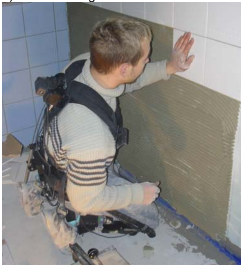
Abbildung 68: Fliesenleger, Tätigkeitsmodul „Wandfliesen verlegen (Dünnbett)“
