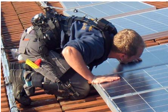
a) Module ausrichten
