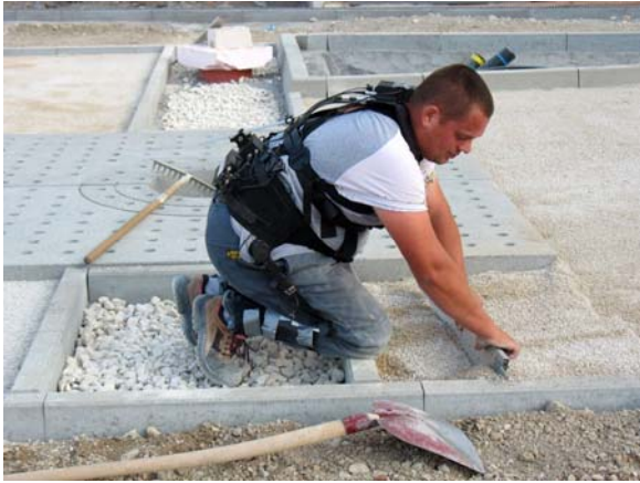
Abbildung 106: Pflasterer, Tätigkeitsmodul „Kleinpflaster verlegen“
