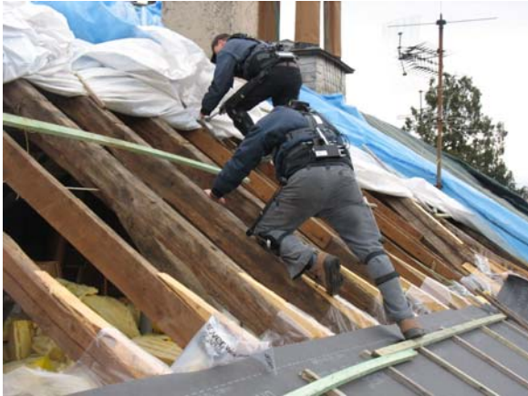
a) Dach vorbereiten
