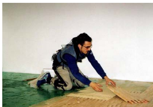
b) Verlegen (Knien ohne Abstützung)
