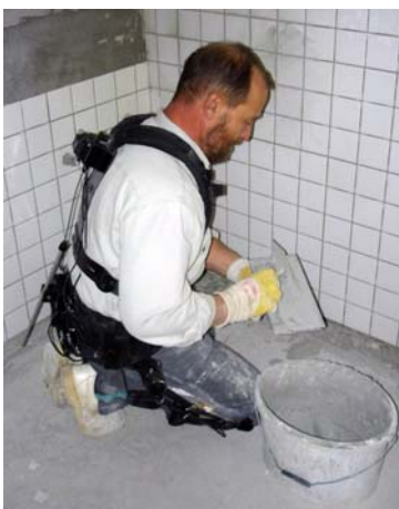
Abbildung 70: Fliesenleger, Tätigkeitsmodul „Wandfliesen verfugen“
