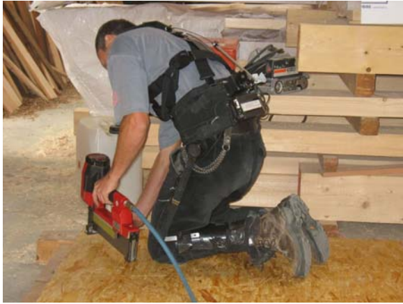
a) Zusammenbau mit Druckluftnagler
