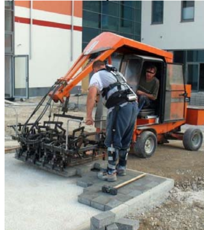
b) Pflasterer mit hydraulischer Verlegezange
