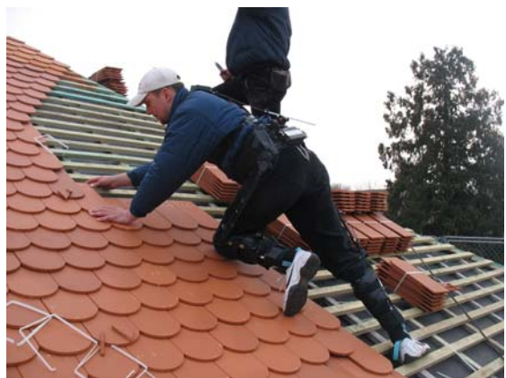
Abbildung 16: Sonderfall: Abgestütztes Knien auf der Dachschräge (Dachdecker)
