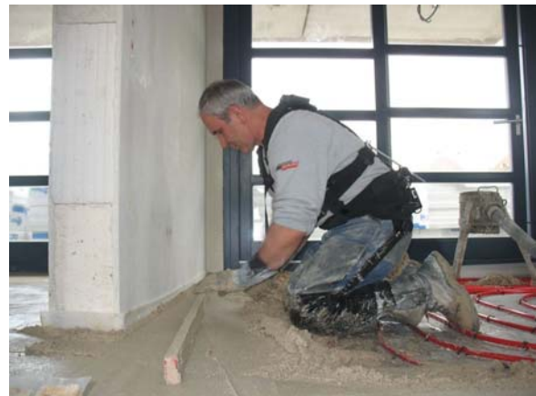
Abbildung 64: Estrichleger, Tätigkeitsmodul „Zementestrich glätten (Drei-Mann-Kolonne)“
