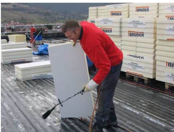
a) Dämmung verlegen (Fläche)
