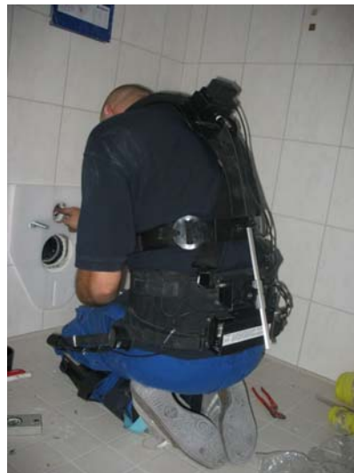
b) WC-Montage vorbereiten
