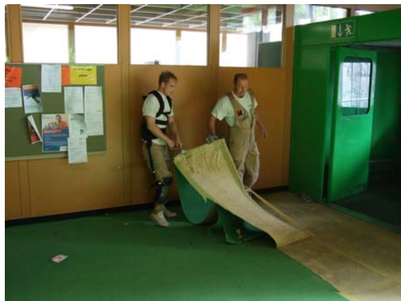
b) Altbelag abziehen
