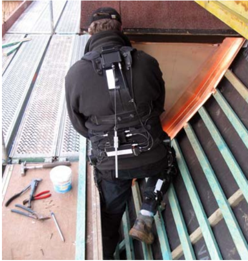
a) Anschlussbleche montieren
