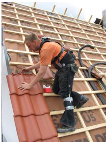
Abbildung 15: Sonderfall „Abgestütztes Stehen“ (Dachdecker)
