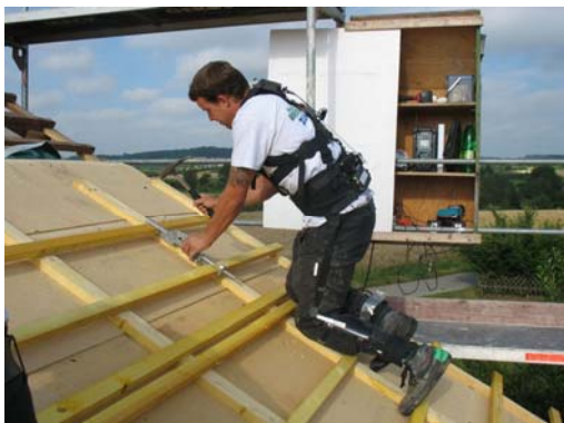
a) Einlatten mit Latthammer
