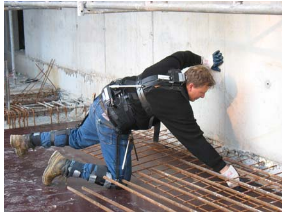
Abbildung 14: Einbeiniges Knien mit Abstützung an der Wand (Betonbauer)
