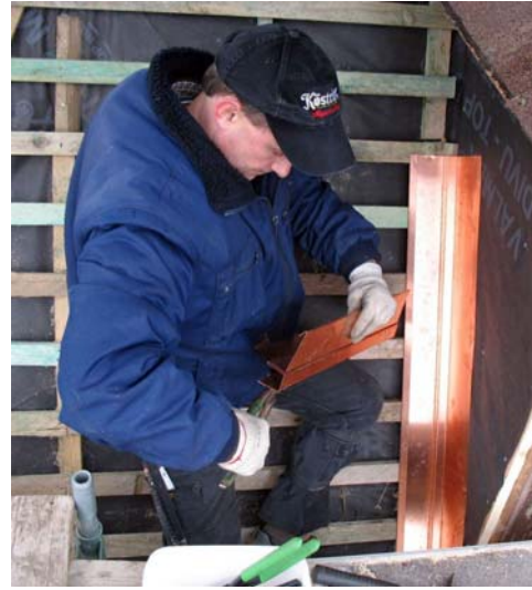
b) Anschlussbleche zuschneiden
