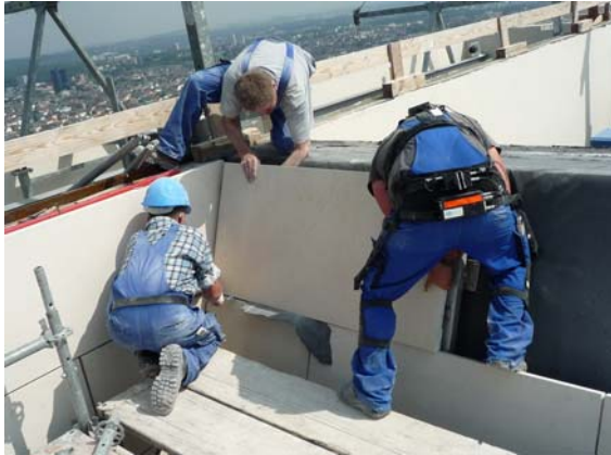
a) Montage der obersten Platten
