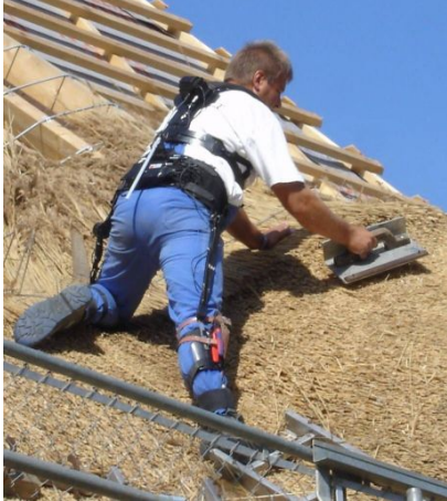
a) Eindecken im abgestützten Stehen
