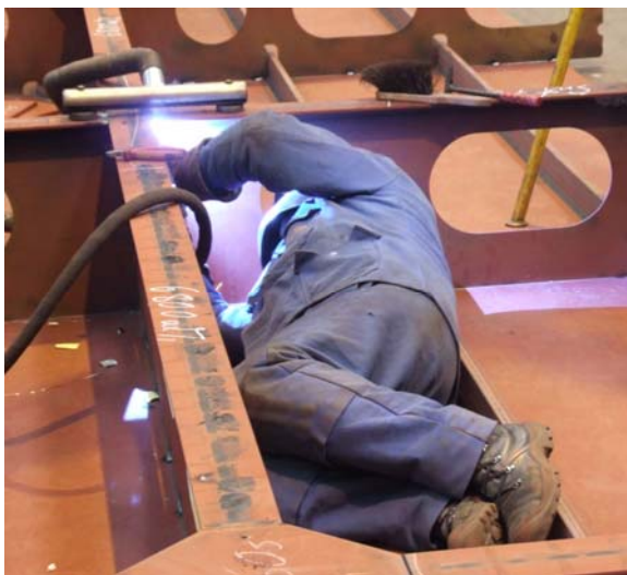
a) Schweißarbeiten im Liegen
