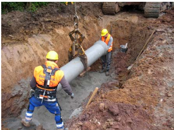
a) Rohrleitung verlegen
