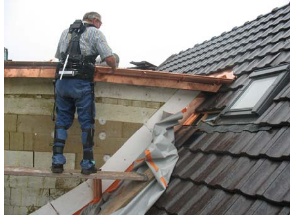
b) Montage (stehend auf Gerüst)
