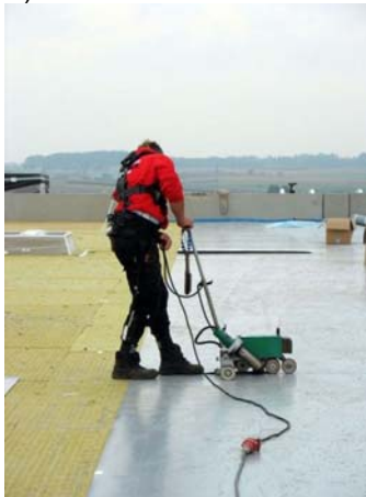
b) Dachdecker mit Heißluft-Schweißautomat
