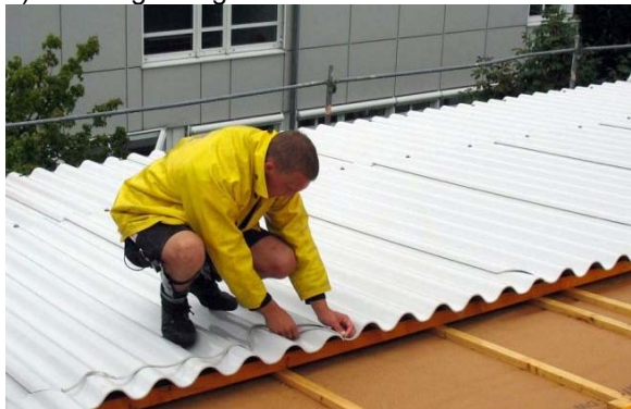
b) Dichtung einlegen
