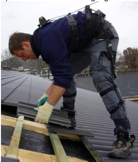
a) Eindecken bei Dachneigung < 40°
