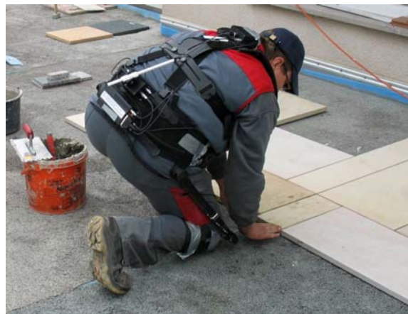
b) Platten verlegen
