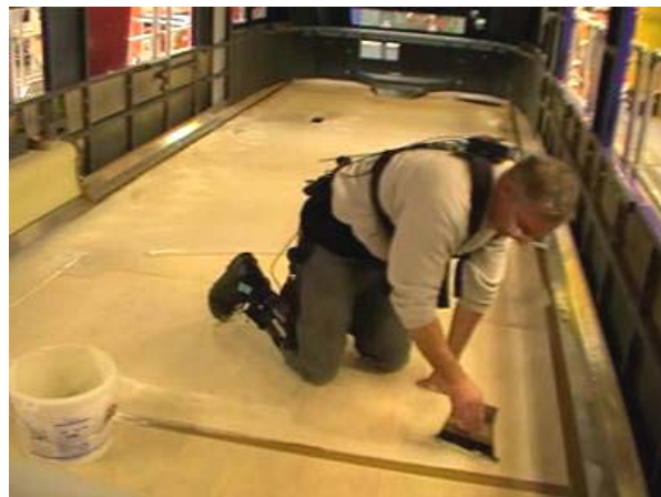
b) Kleber auftragen
