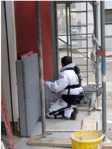
Abbildung 90: Maler und Lackierer, Tätigkeitsmodul „Vollwärmeschutzmontage“
