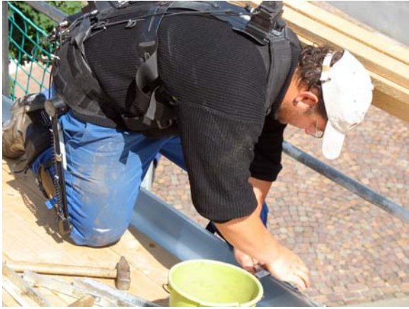
a) Montage (kniend auf Dachfläche)
