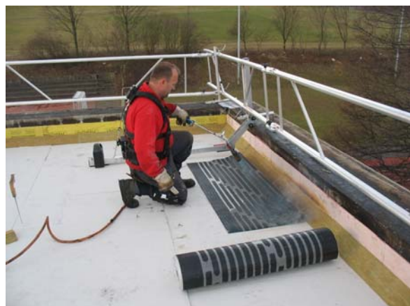
b) Schweißbahn im Randbereich verlegen
