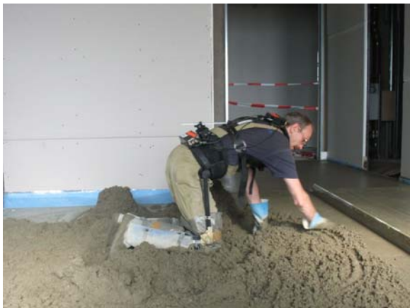
Abbildung 64: Estrichleger, Tätigkeitsmodul „Zementestrich glätten (Drei-Mann-Kolonne)“
