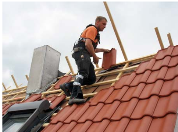
b) Eindecken bei Dachneigung > 40°
