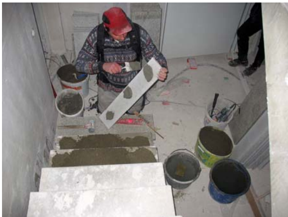
Abbildung 94: Natur- und Kunststeinleger, Tätigkeitsmodul „Treppenstufen verlegen“
