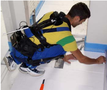
a) Dämmung verlegen
