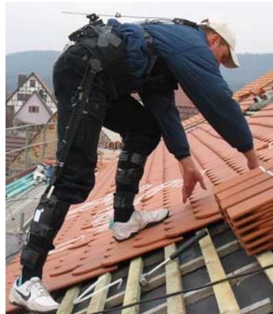
b) Eindecken im Stehen
