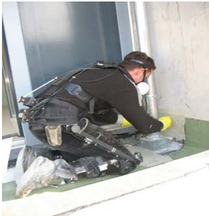
Abbildung 56: Dachdecker, Tätigkeitsmodul „Flachdach: Anschluss mit Flüssigfolie“
