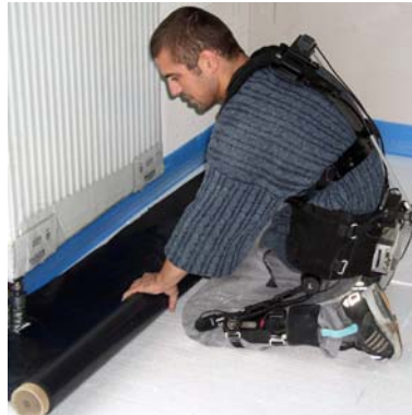
b) PE-Folie verlegen
