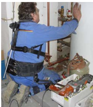
a) Anschlussarbeiten im Knien
