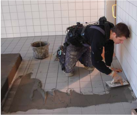
Abbildung 69: Fliesenleger, Tätigkeitsmodul „Bodenfliesen verfugen“
