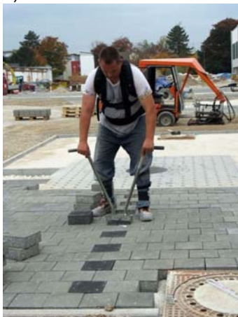
a) Pflasterer mit Pflastersteinzieher
