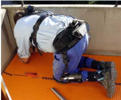
Abbildung 72: Fliesenleger, Sonderfall „Bodenfliesen verlegen (Dickbett)“
