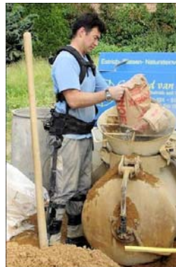
b) Zement einfüllen
