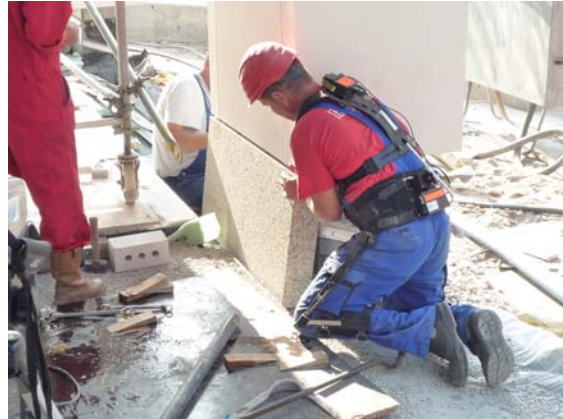
b) Montage im Sockelbereich
