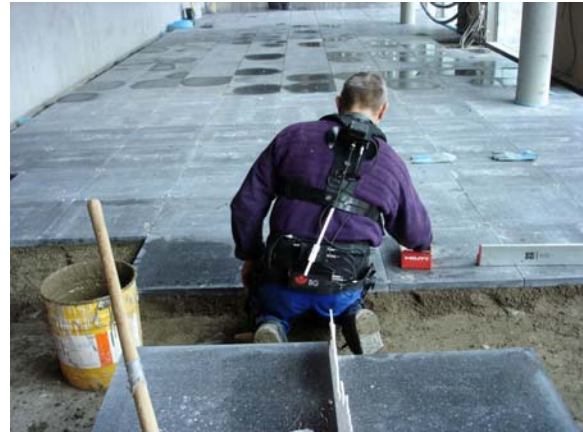
b) Vakuumheber: Bodenplatten verlegen
