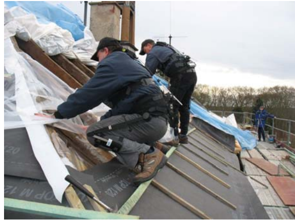
b) Dampfsperre befestigen
