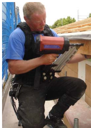
Abbildung 9: Einbeiniges Knien ohne Abstützung (Dachdecker)
