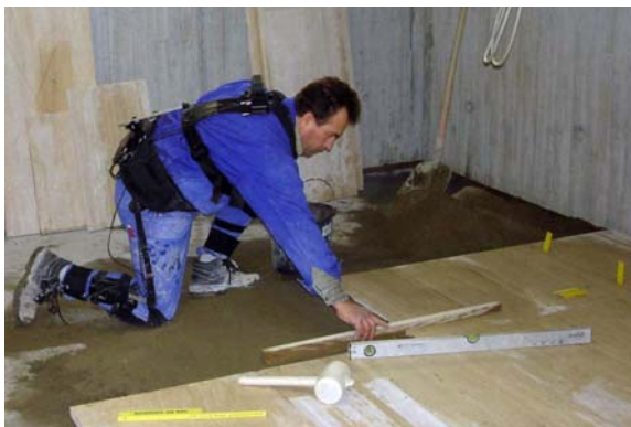
Abbildung 72: Fliesenleger, Sonderfall „Bodenfliesen verlegen (Dickbett)“
