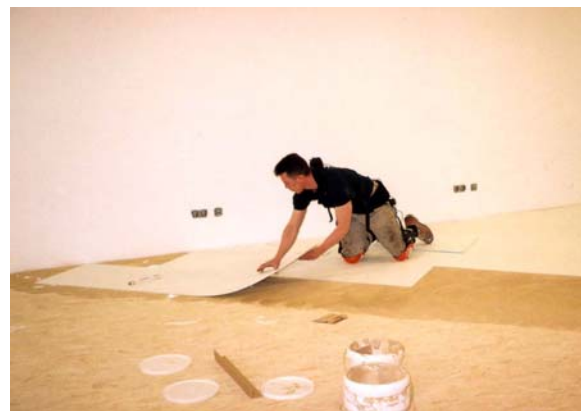
b) Trittschalldämmung verlegen
