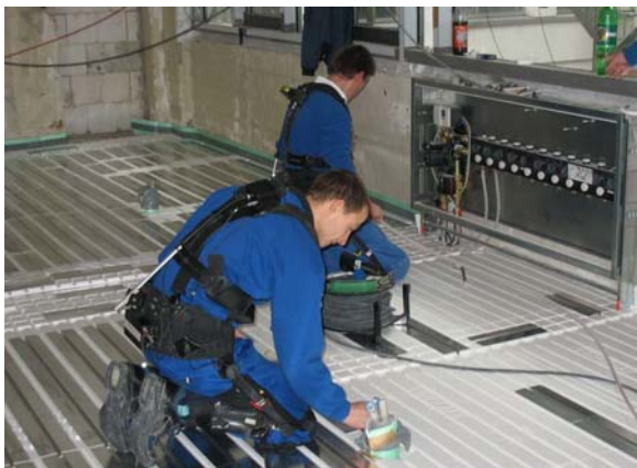
Abbildung 76: Installateur, Tätigkeitsmodul „Fußbodenheizungs-Vorbereitung“
