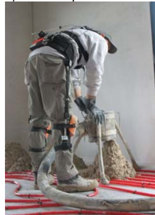
Abbildung 64: Estrichleger, Tätigkeitsmodul „Zementestrich glätten (Drei-Mann-Kolonne)“
