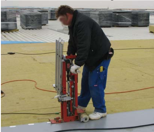
a) Dachdecker mit Flachdachsetzgerät
