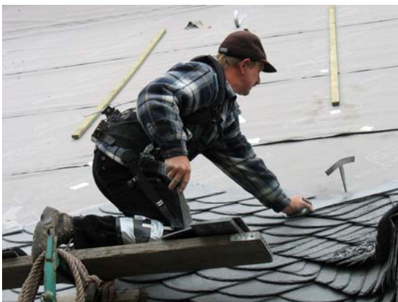
a) Knien auf Dachgerüst
