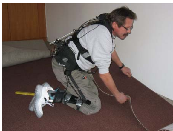
b) Teppich verlegen
