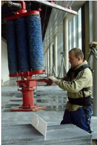
a) Vakuumheber: Bediener
