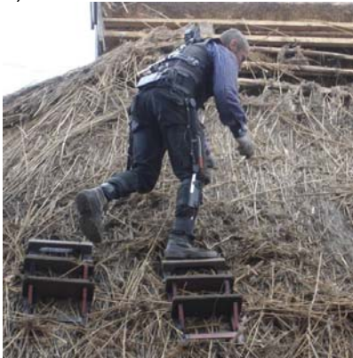
a) Dach abdecken
