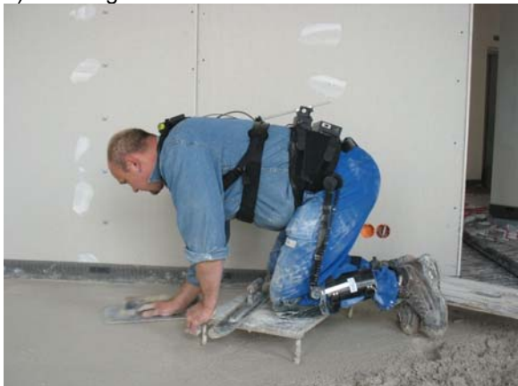
Abbildung 64: Estrichleger, Tätigkeitsmodul „Zementestrich glätten (Drei-Mann-Kolonne)“
