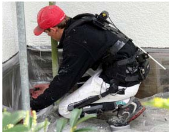
b) Abkleben im Sockelbereich
