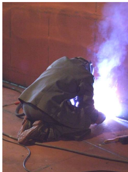
b) Schweißarbeiten im Knien
