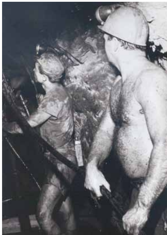
Bei solchen Bohrarbeiten waren die Bergleute einer hohen Belastung durch radioaktiven Staub ausgesetzt, bevor man um 1955 auf Nassbohrverfahren umstellte.
