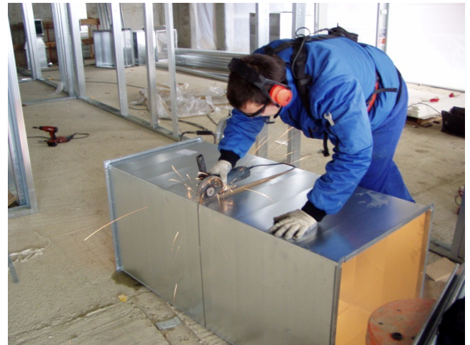
Lärmarbeitsplatz eines Lüftungsbauers
