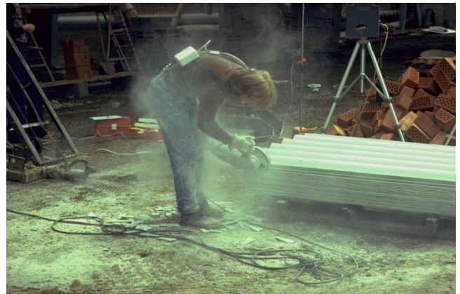
Asbestfaserexposition bei der Bearbeitung von Wellasbestzementplatten mit der Flex (der Einsatz von Trennschleifern wurde 1981 verboten), Bild: Woitowitz, "Baustellenstudie Hessen"
