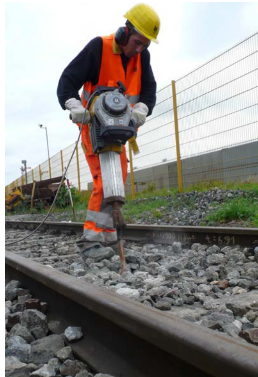
Einwirkung von Hand-Arm-Vibration, Beispiel: Gleisstopfen
