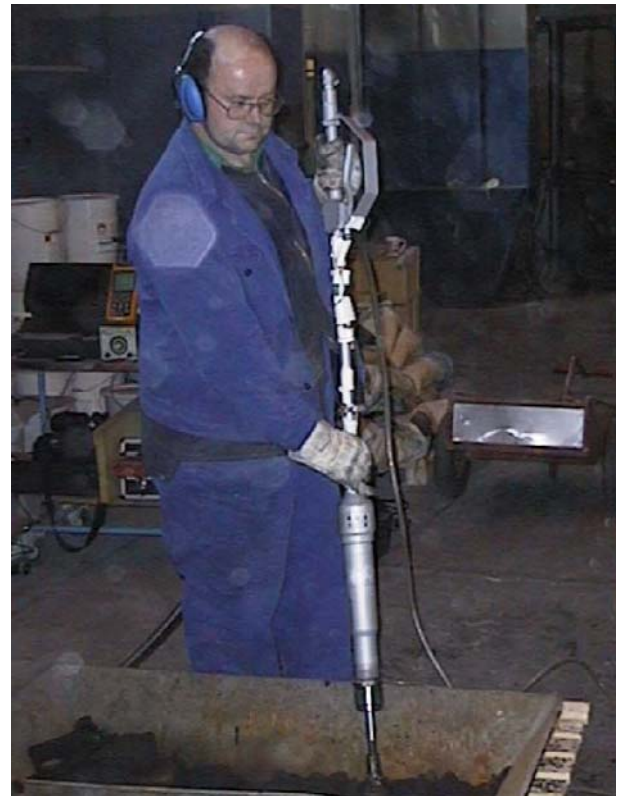
Druckluft-Stampfer beim Verfestigen von Ofenausmauerungen
