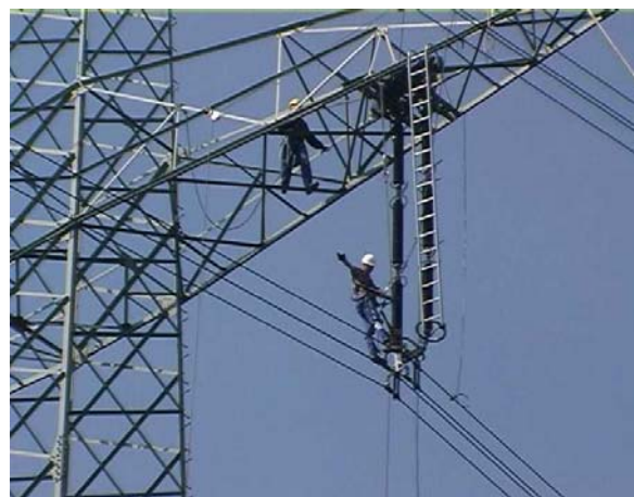
Typische Arbeitssituation im Freileitungsbereich
