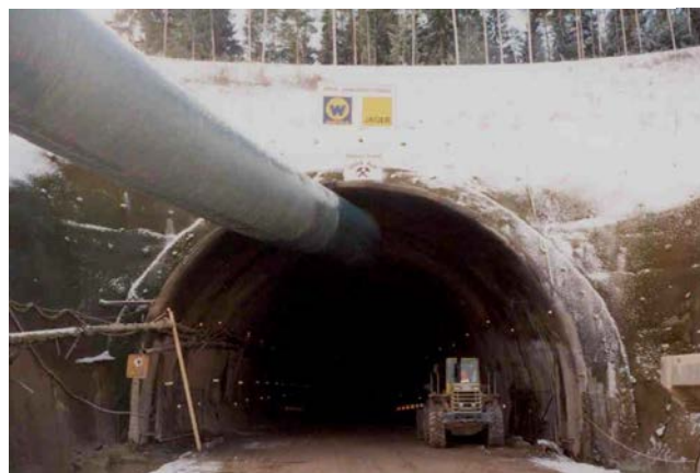
Sprengvortriebarbeiten in einem belüfteten Tunnel
