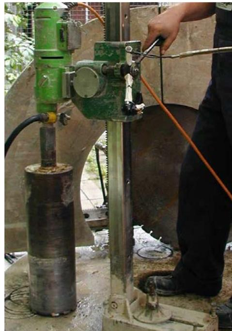
Erstellung von Kernbohrungen mit und ohne Führungsgestänge
