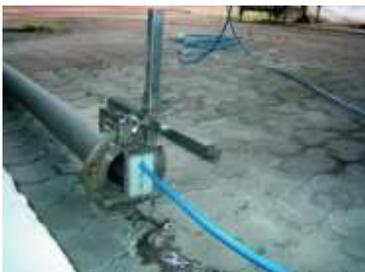
**Abb. 3-8: Beispiel einer Fangvorrichtung bei der Rohrreinigung**
