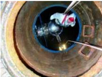
**Abb. 3-17: Vorbereitende Arbeiten zur Kanalinspektion (Einsetzen der Rohrkamera)**
