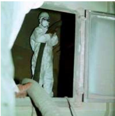
**Abb. 3-15: Atem- und Körperschutz bei Saugarbeiten. Eine bessere Schutzwirkung als die hier abgebildete FFP-Maske bieten Halb- oder Vollmasken mit Partikelfiltern, z. B. P2, oder: umgebungsluftunabh. Atemschutz (vgl. Strahlenschutzanzug, Abb. 3-10)**
