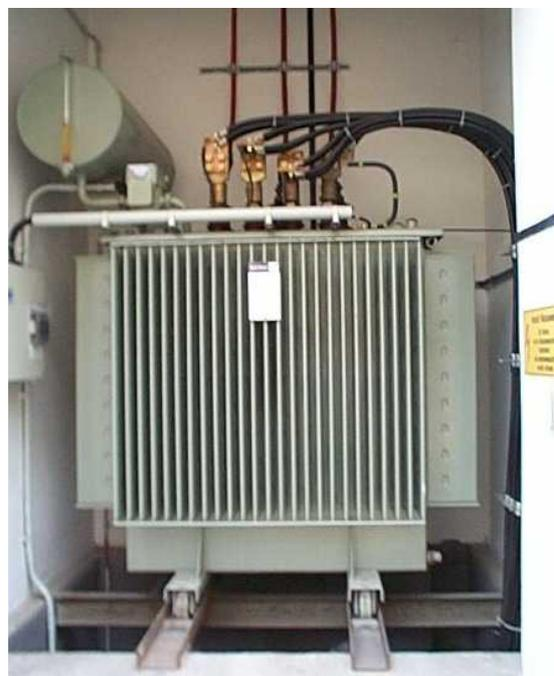
Netzspannungstransformator getrennt von der Mittelspannungs- und Niederspannungsverteilung
