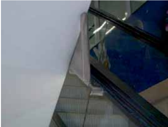
Bild 2: Vermeidung von Einzugs- gefahr
