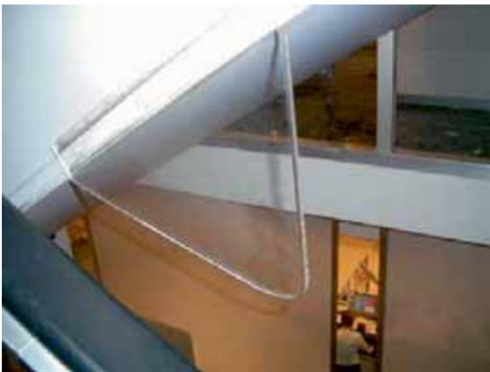
Bild 3: Einzugsgefahr durch zu kurze Abweiser
