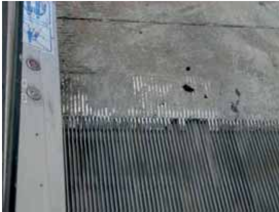
Bild 18: beschädigter Kamm
