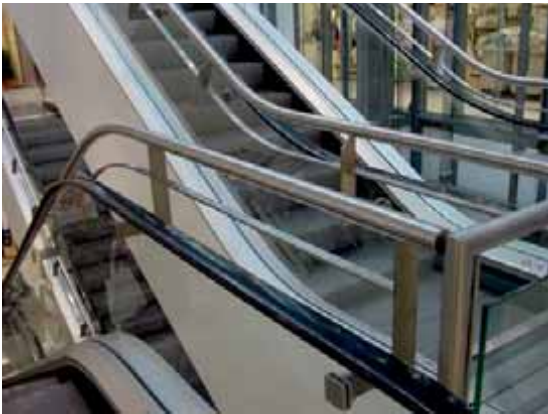
Bild 5: Vermiedene Einzugs- gefahr
