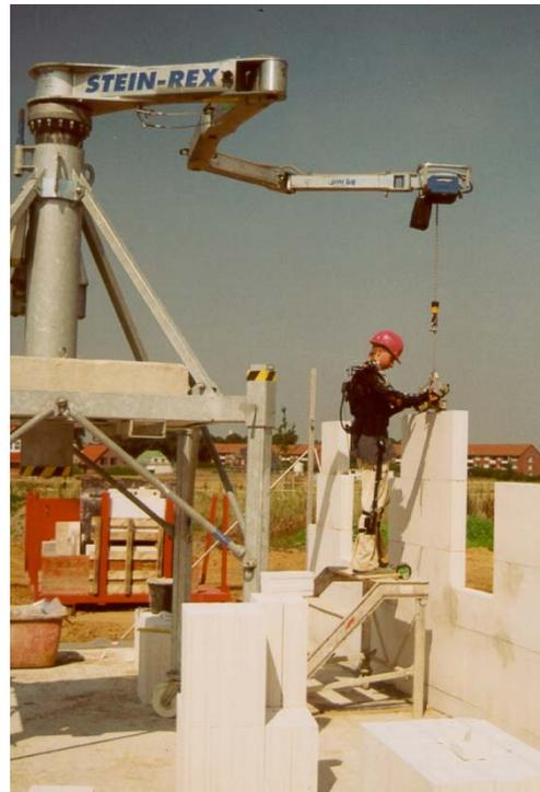
Erfassung von Körperhaltung und gehandhabtem Lastgewicht beim Mauerwerksbau mit einem Minikran als Versetzhilfe
