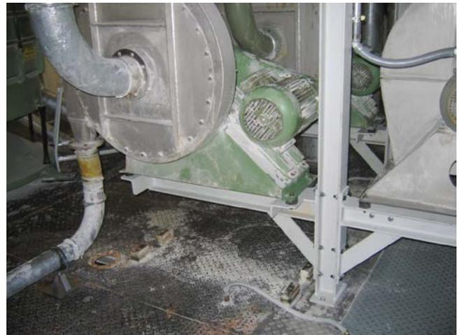
Von der Bodenplatte entkoppelte schwingungs isolierte Aufstellung von Ventilatoren
