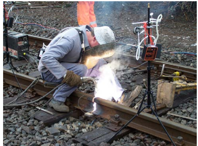
Verschweißen der Schienenstöße
