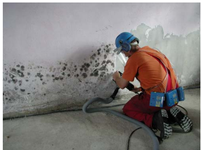
Entfernen von verschimmeltem Wandmaterial
