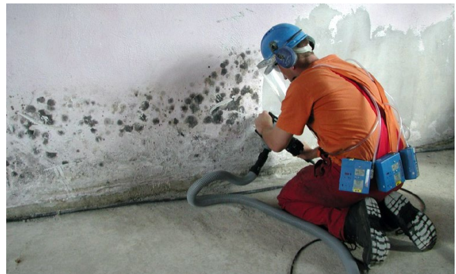
Entfernen von verschimmeltem Wandmaterial. Bild: IFA
