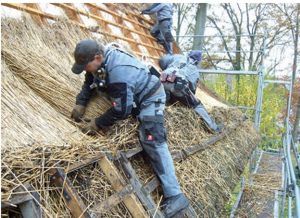
Reetdachdecker mit Probennahmesystem
