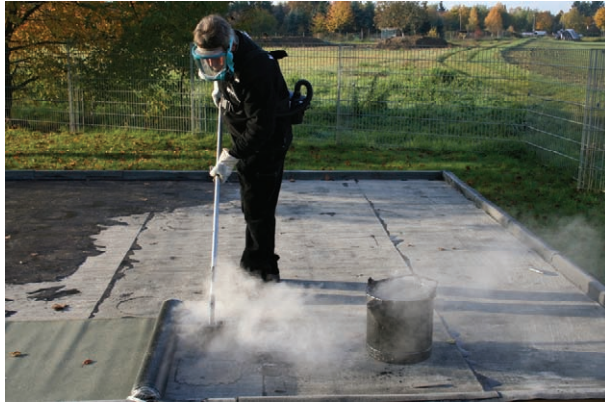
Expositionsmessung bei nachgestellten Dachdeckerarbeiten
