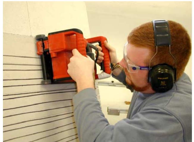
Mauernutfräse beim Schlitzfräsen in Kalksandsteinmauerwerk
