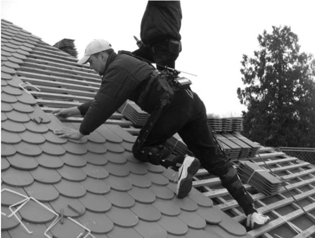
Abbildung 67: Sonderfall: Abgestütztes Knieen auf der Dachschräge (Dachdecker)
