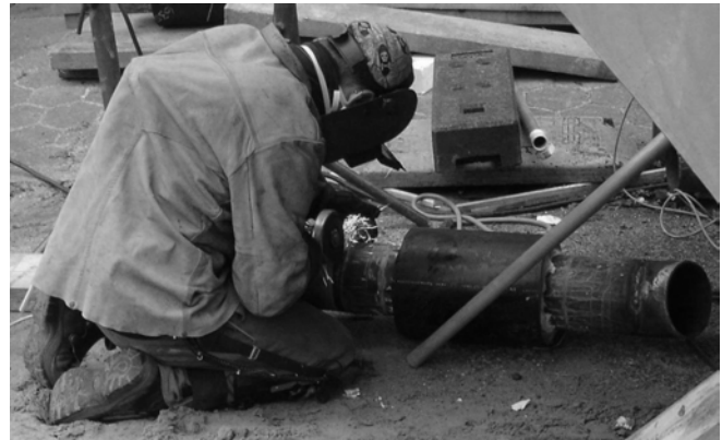
Abbildung 73: Vermeiden knieender Haltung durch Anpassen der Arbeitshöhe (Beispiel Rohrleitungsbauer) oben: ohne Hilfe, unten: mit Hilfe
