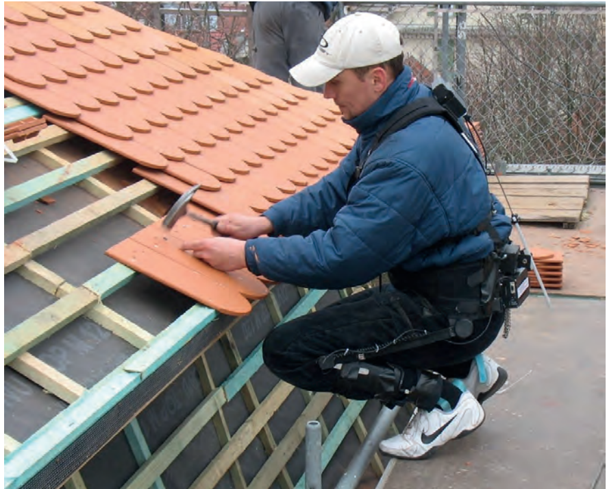
Dachdecker mit CUELA-Messsystem
