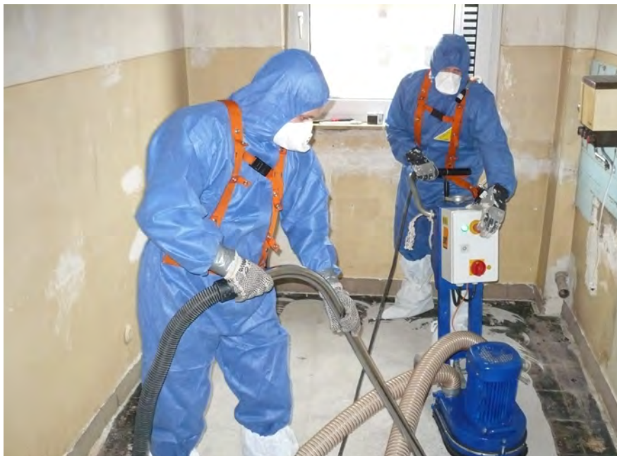
Abschleifen asbesthaltigen Bodenbelagsklebers in einem Wohnraum (Bild: svt-Brandschutz GmbH)
