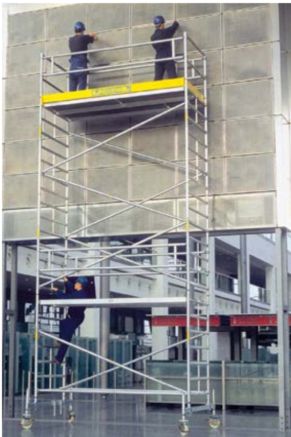
Abb. 4-17 Korrekt aufgebauete fahrbare Arbeitsbühne
