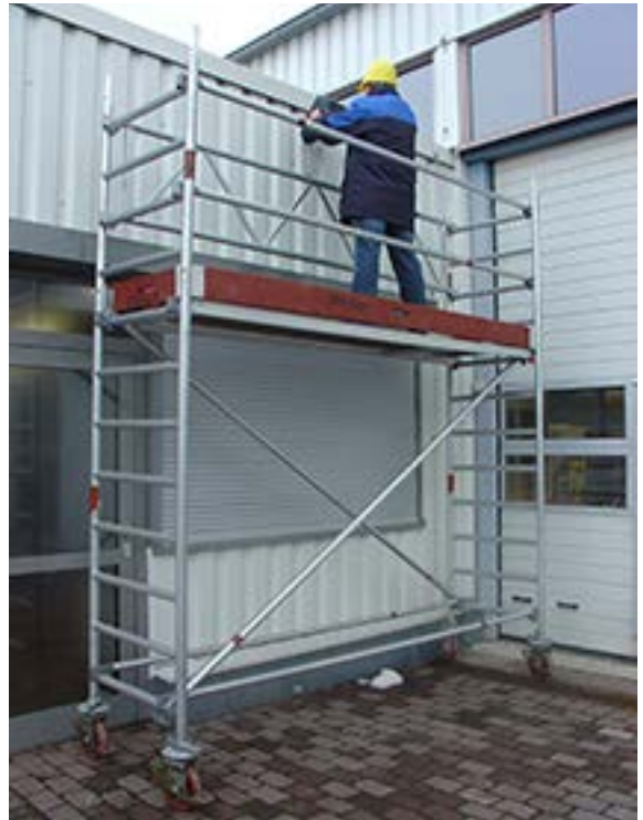
Abb. 3-10 Fahrbare Arbeitsbühne nach DIN EN 1004:2005-03
