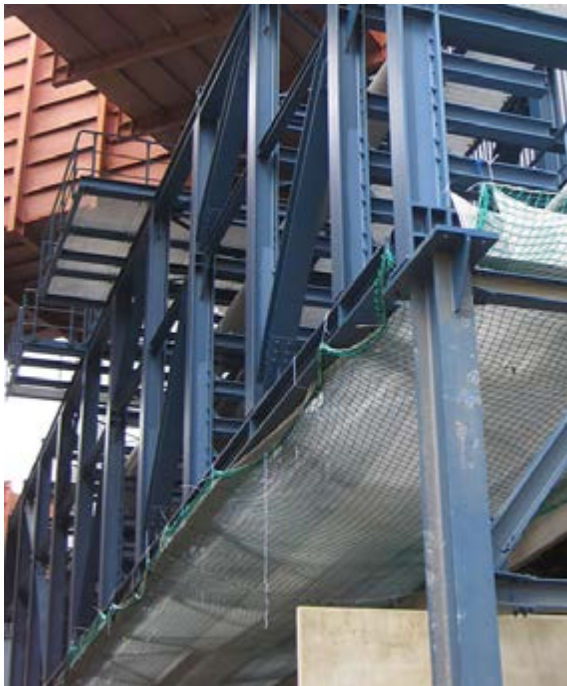
Abb. 4-9 Einsatz eines Schutznetzes zur Montage von Rosten
