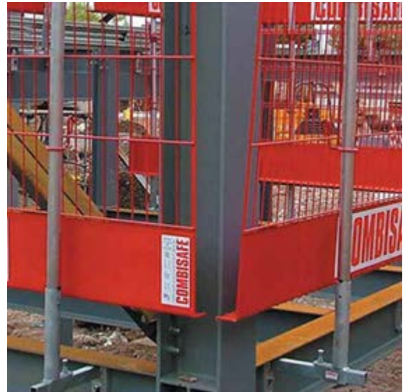
Abb. 4-3 Beispiel eines temporären Seitenschutzes
