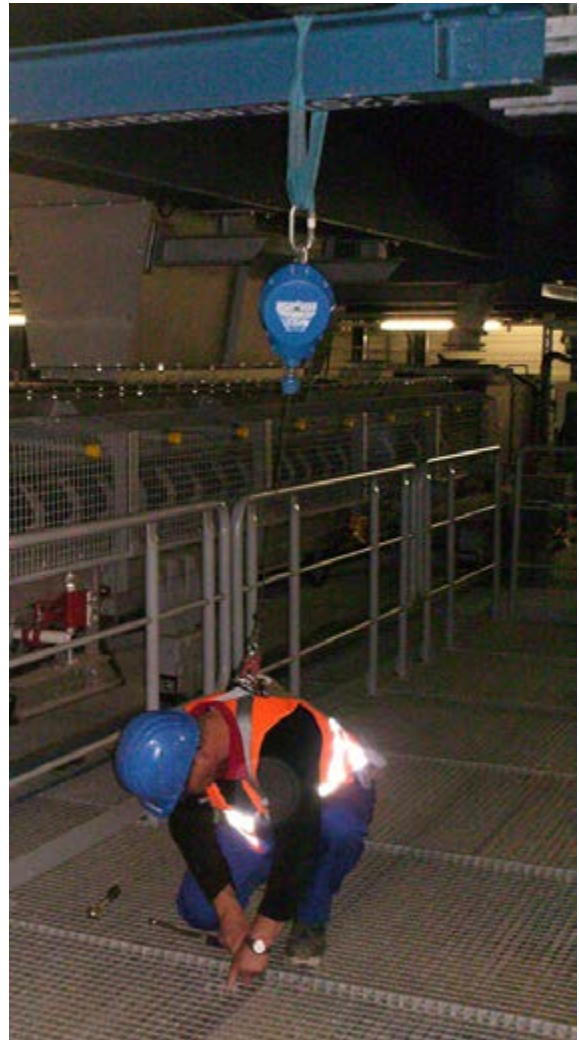
Abb. 4-16 PSA gegen Absturz mit Höhensicherungsgerät
