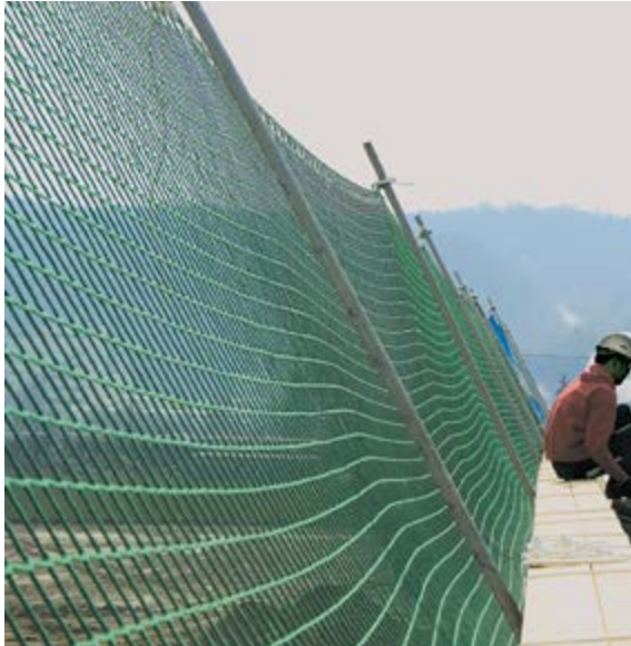
Abb. 4-5 Randsicherung mit Schutznetzen
