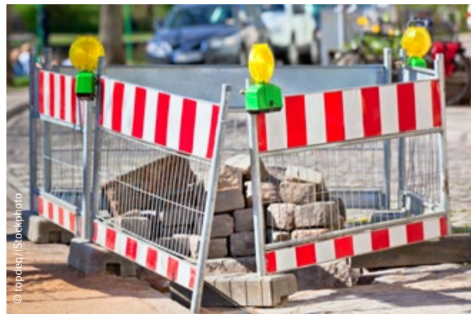
Abb.3 Baustelle mit Baken und Lichtzeichen gesichert
