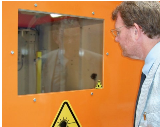
Abb. 45 Sichtfenster an einer Laserschweißanlage [H]
