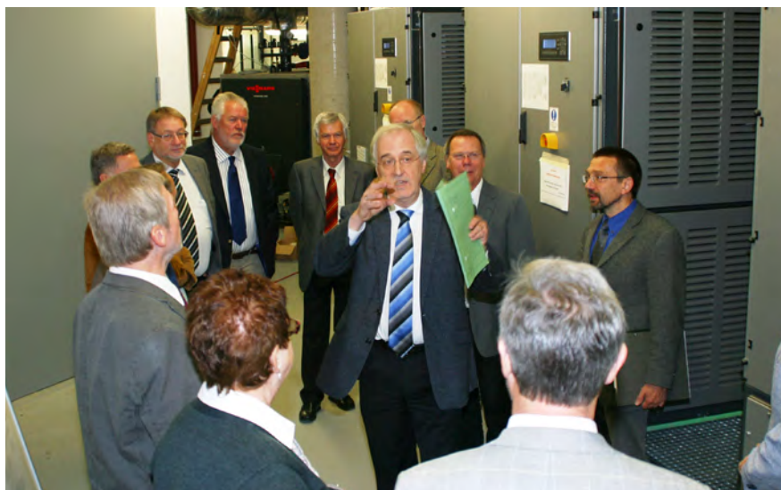
Besuch des Finanzausschusses der DGUV im neuen Blockheizkraftwerk
