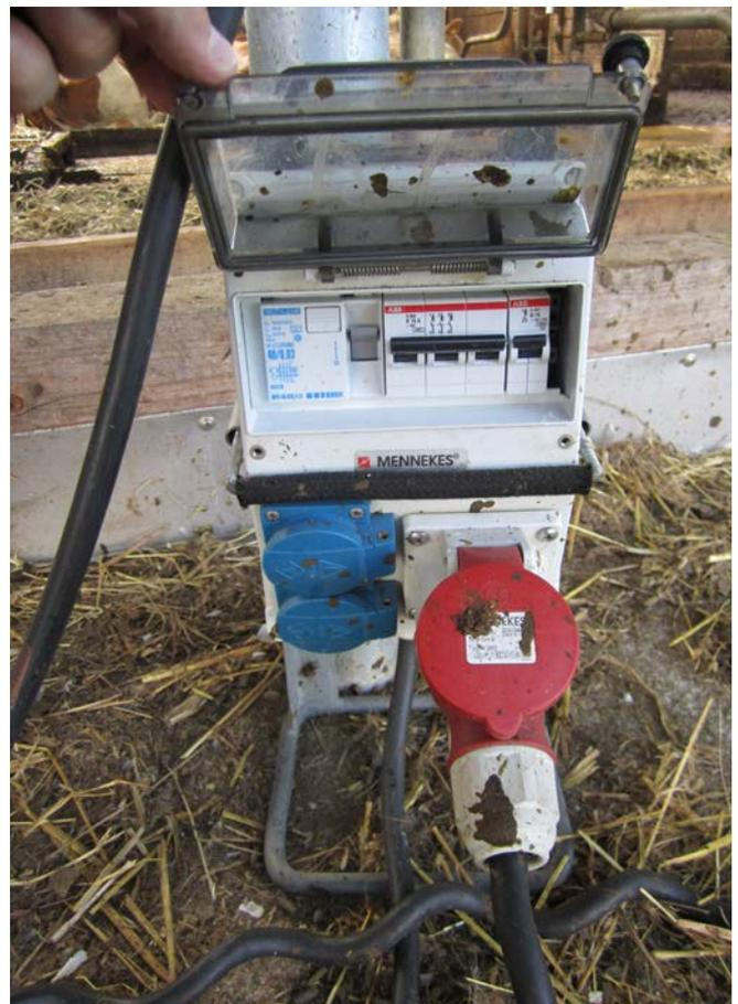
Abb. 12-3 Elektrokleinverteiler mit eingebautem Fehlerstrom- und Leitungsschutzschalter
