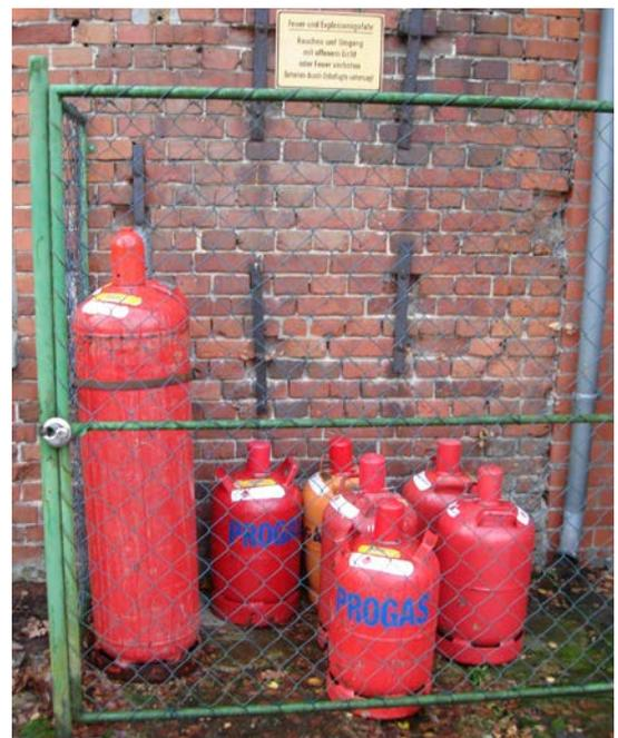
Abb. 8-2 Lagerung gefüllter Druckgasbehälter im Freien
